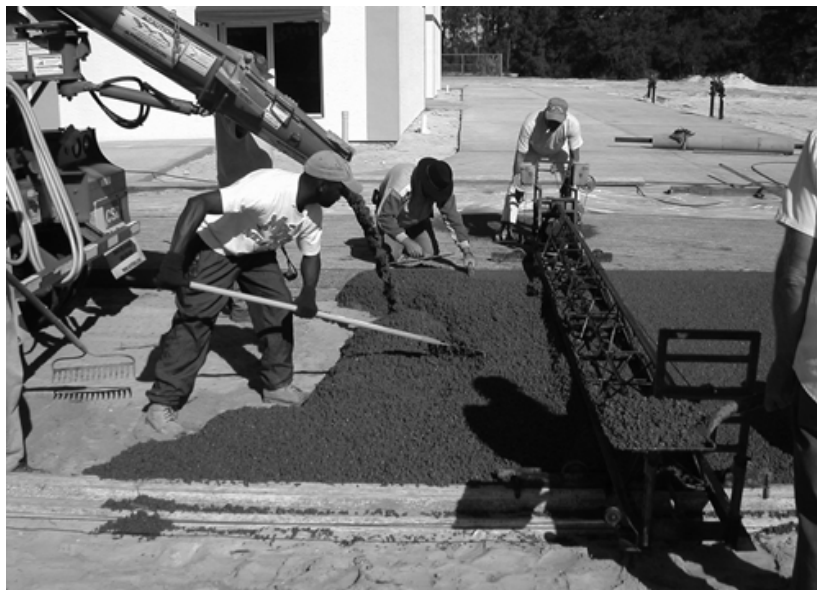
Figura 5.9: Aplicação de vibração com uma vibroacabadora sobre uma pavimentação. (Fonte: ACI, 2006)
