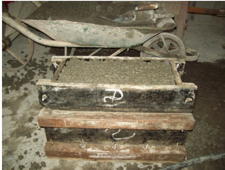
Figura 4.4: Fôrma nas dimensões 30 X 45 X 15 cm. (Fonte: Arquivo do Pesquisador)
