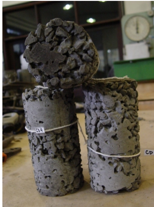
Figura 4.3: Aspecto de corpo de prova de um traço com relação a/c de 0,45, mostrando poros obstruídos (Fonte: Arquivo do Pesquisador)
