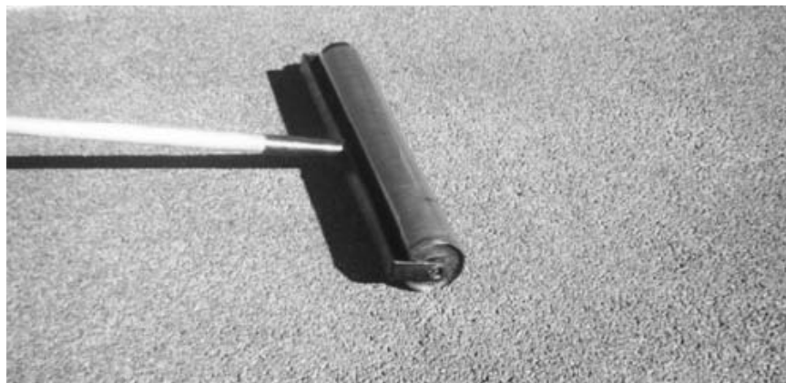
Figura 3.1: Rolo compressor usado na pavimentação com concreto permeável (Fonte:Norma do ACI 522R-06)
