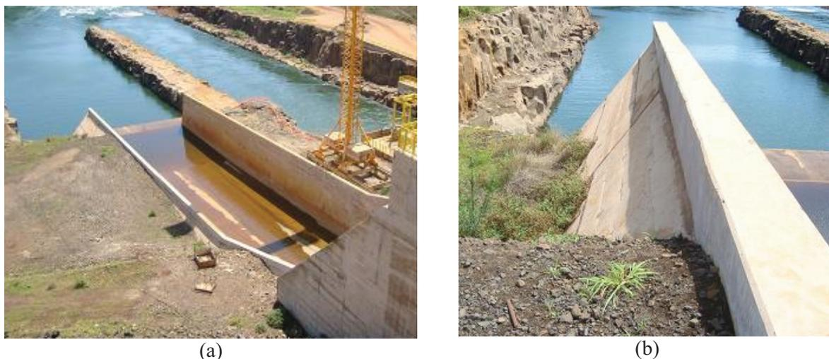
Figura 6.10: Foto dos muros da calha do vertedouro. (a) Visão geral da calha. (b) Detalhe do muro.
