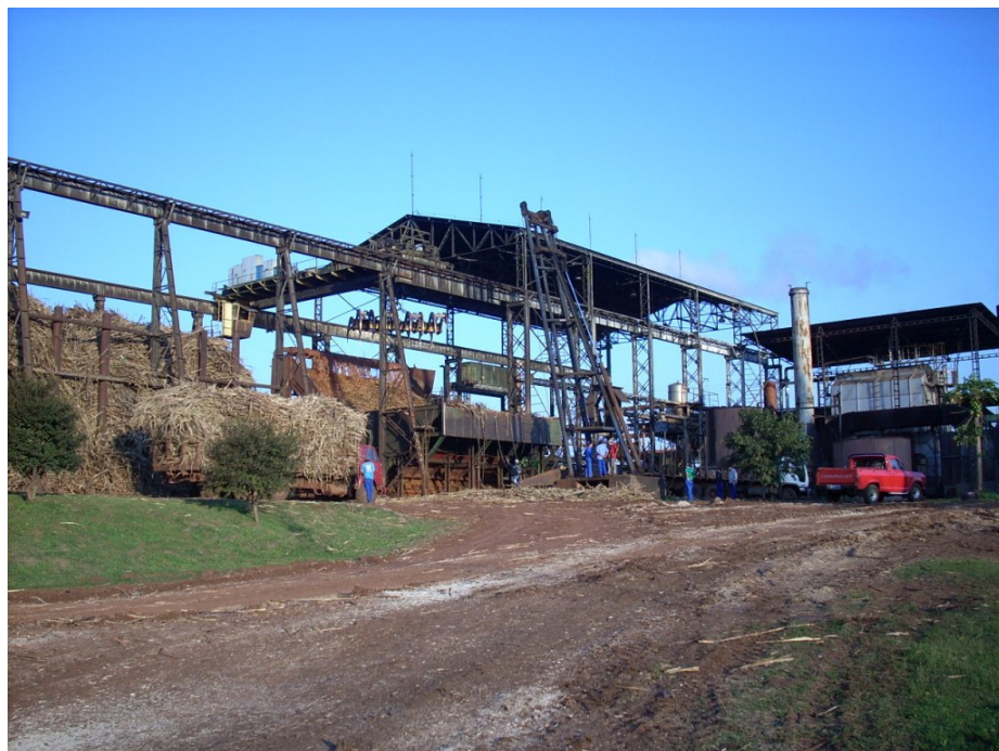
Figura 1 - Vista do setor de recepção e lavagem da usina da Coopercana – Porto Xavier
