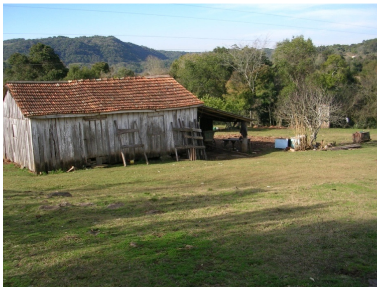
Figura 10 - Galpão da UPA 1 na visita realizada em agosto de 2009
