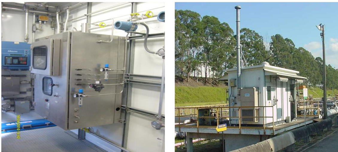
Figura 4. Analisador de hidrocarbonetos acondicionado de maneira segura para não sofrer danos e nem gerar riscos à indústria petroquímica. Fonte: Célio Pasquini, UNICAMP, 2011
