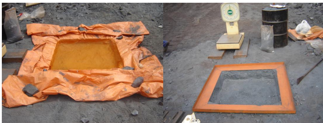
Figura 2.5 – Realização do ensaio de densidade pela Técnica da Abertura de Poço ou Cubo (Santos, 2006).
