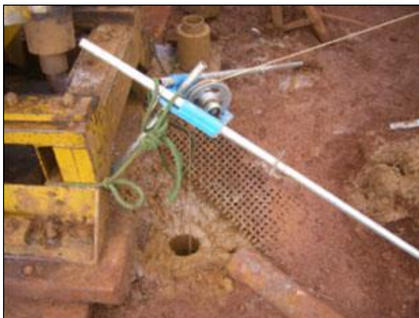
Figura 4.1 – Montagem improvisada do equipamento de perfilagem logo após o furo ser finalizado.
