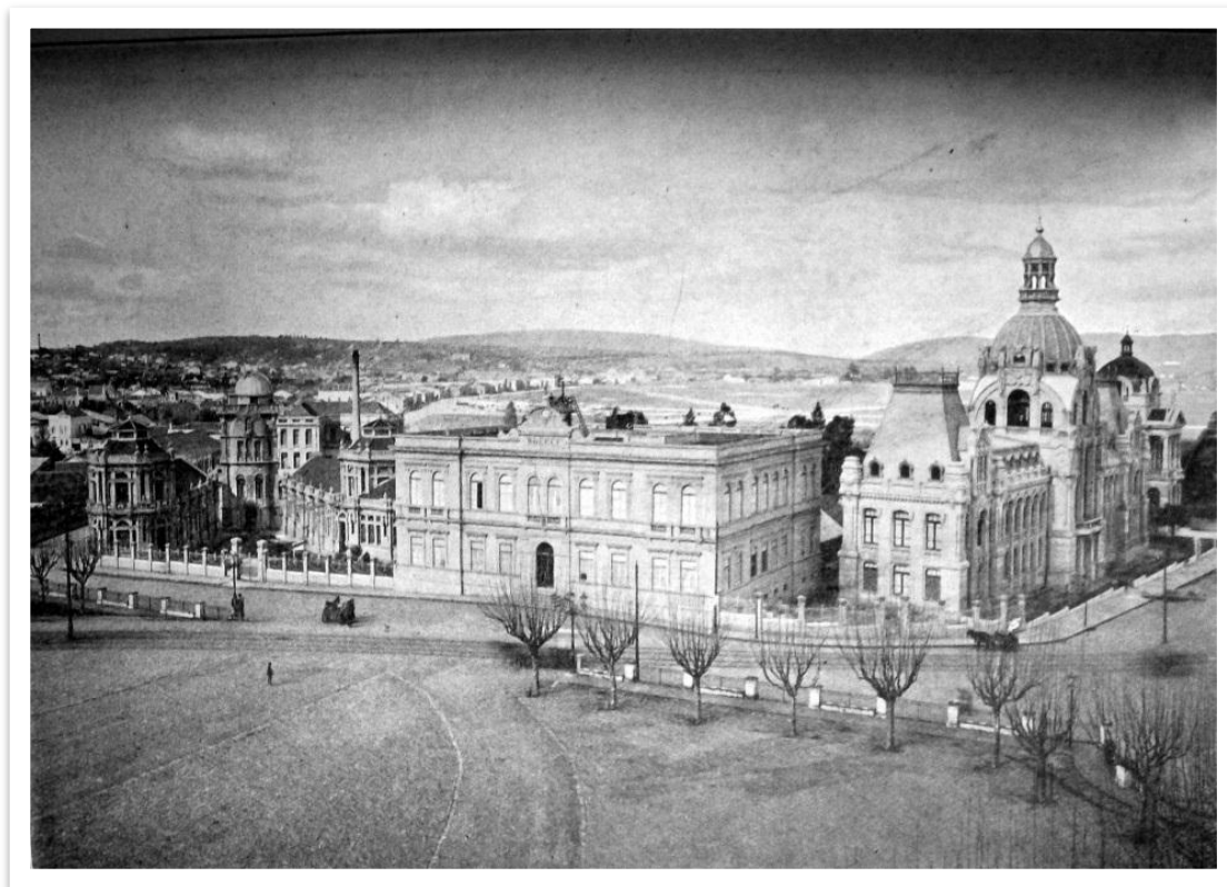
Figura 2.5: Escola de Engenharia
