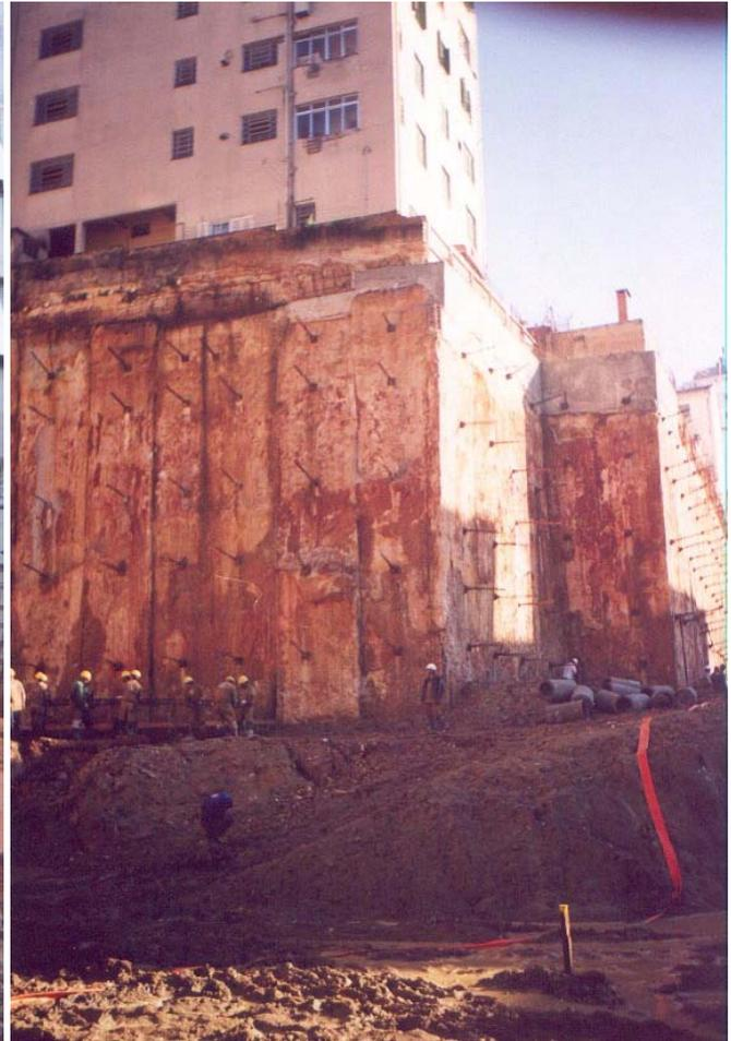
Figura 3.7 - Escavação da Parede Diafragma
