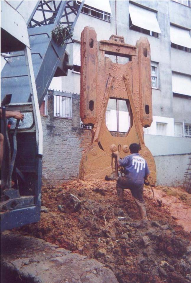
Figura 3.6 - Início da Construção da Parede Diafragma com "Clam Shell".
