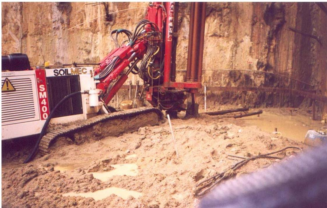
Figura 3.8 - Execução das estacas injetadas de pequeno diâmetro.
