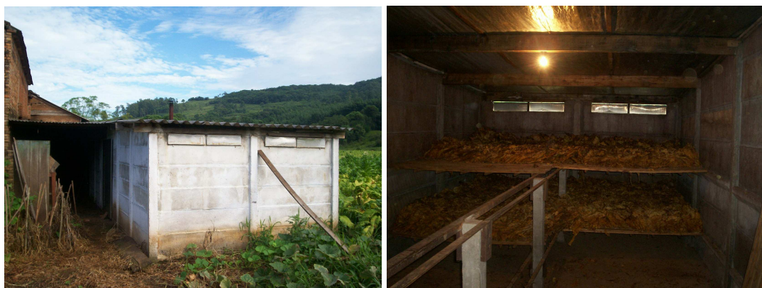
Fotografia 2 Modelo LL de estufa de secagem de fumo Foto: Herbert Fischborn
