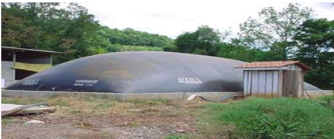
Figura 7 – Biodigestor.
