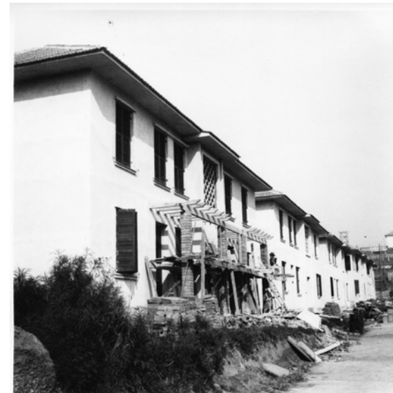
Blocos tipo G2S , com fachada de pergolado , em construção.
