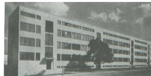
Edifício de Walter Gropius, para Berlin (acima) e de Mies, para Stuttgart (abaixo), onde estão bem marcadas as principais características da arquitetura alemã do período: prédios de quatro pavimentos de altura com ocupação integral do térreo e platibandas altas, onde predominam as linhas retas e a ausência de decorativismo.
