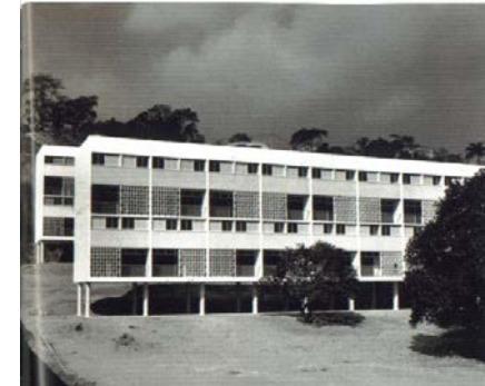
Vista dos dois Blocos do tipo B.
