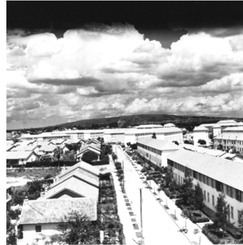
Vista de uma área residencial da Vila com o prédio do Grupo Escolar ao fundo.
