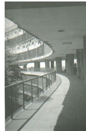
Pátio coberto do Bloco A: a solução do pilotis em pavimento intermediário, por conta das características do terreno.
