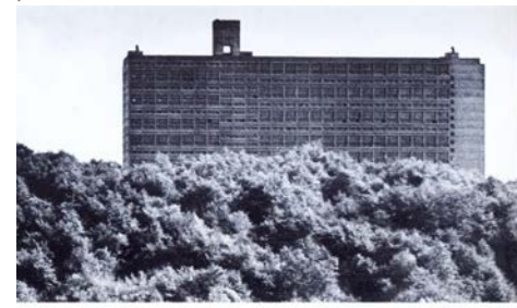
Unité de Marseille, de 1952 (acima) e Unité de Briey en Forêt, de 1959 (abaixo), cercadas de verde: cidades-jardim verticais.
