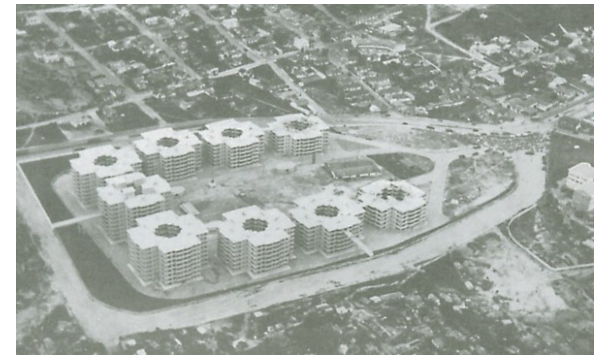
Vista aérea do conjunto da Lagoinha, em Belo Horizonte, formando, com a justaposição dos seus blocos em cruz, um corpo maior de aspecto monumental jogado sobre o alinhamento do passeio liberando um espaço central para uso dos moradores, lembrando algumas características dos Höf vienenses.
