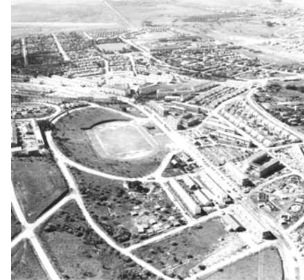
Vista aérea do conjunto em obras, apresentando a grande concentração de prédios de habitação coletiva inexistentes na proposta de Sabóia que com o aumento da densidade resultante, no entanto, não comprometeram o espírito inicial do projeto.
