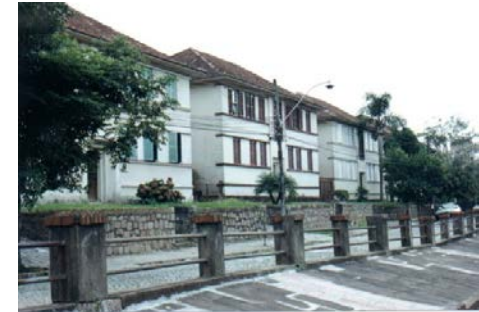
Blocos de apartamentos da vila do LAPI: boa conservação.
