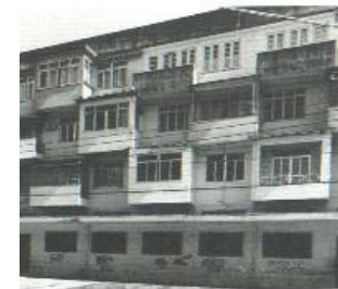
Pedregulho e Realengo em fotos recentes, demonstrando o grau de descaracterização em que se encontram atualmente.
