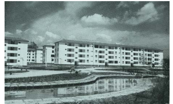
Vista dos blocos do Conjunto Residencial da Penha, no Rio de Janeiro onde aparecem novamente os prédios de quatro pavimentos, com ocupação integral do térreo, dispostos em barras paralelas, característicos da arquitetura alemã.
