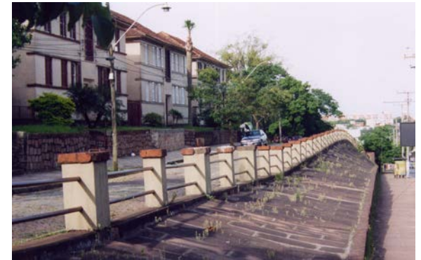
Limite externo junto à Estrada da Pedreira: por informações incorretas contidas no levantamento topográfico original, uma nova via de acesso teve de ser criada para permitir a implantação das unidades ali previstas.
