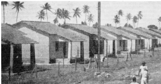
Conjunto de casas populares em construção nos arredores de Recife, 1940: anônimo e despretenso
