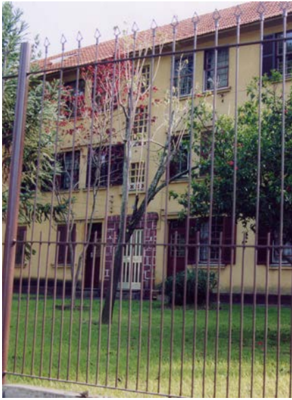
Prédio de habitação coletiva com grande área verde frontal, hoje cercada.
