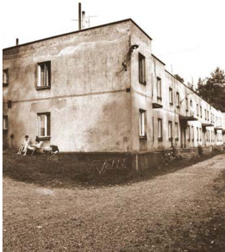
Correr de casas em fita características das Siedlungen. Adolf Loos.
