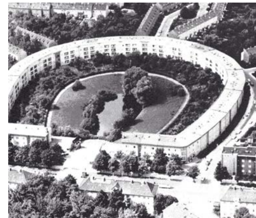
O prédio de Taut, com sua característica forma de ferradura, para a siedlung de Britz , construída nos arredores de Berlin, em 1928.
