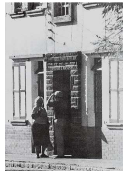
Embasamento e portal em pedra conservados após a reforma de um prédio.
