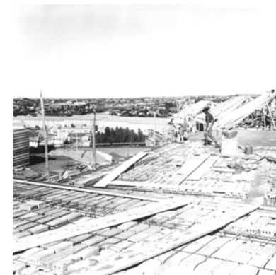
Entrepiso de um prédio de habitação coletiva em laje de tijolo armado, num sinal de que as portas para a inovação não estavam totalmente fechadas.
