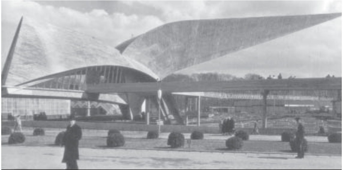
Fig. 71 - Pavilhão da Engenharia Civil demonstrando a utilização da técnica com fins estéticos. (CARDOSO Rui. Bruxelas 1958. Lisboa: Parque EXPO '98, 1998).
