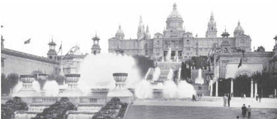
Fig. 47 - Vista do Palácio Nacional e das escadarias, fontes e mirantes que compunham um espaço monumental. (ALMEIDA, Cristina Ferreira de. Barcelona 1929. Lisboa: Parque EXPO '98, 1998).
