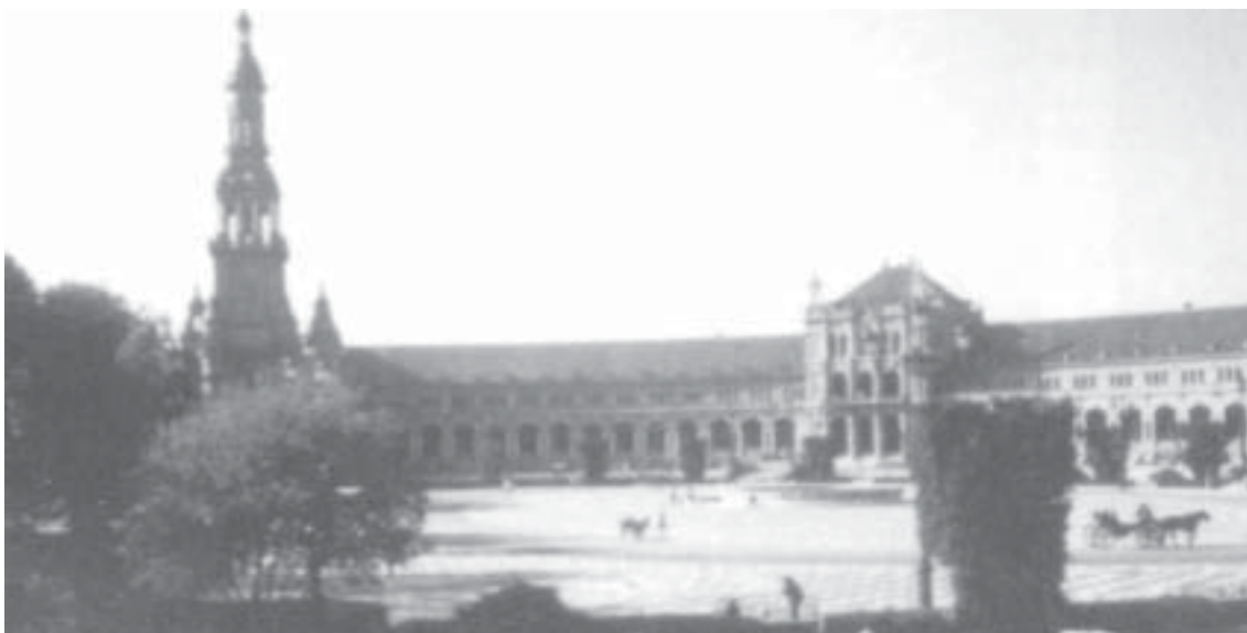
Fig. 27 - Panorâmica geral da Exposição de Sevilha, Espanha, 1929. (DIXON, Jhon Morris. Word on a Platter. Progressive Architecture. n. 7:92).
