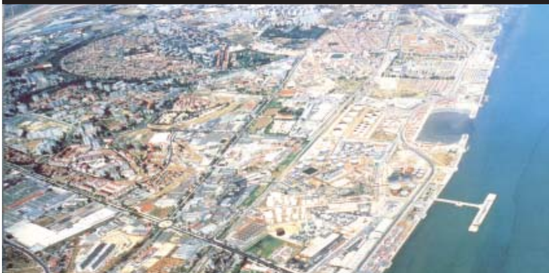
Fig. 90 - Vista da área da exposição antes do evento, composta por grandes parques industriais, pavilhões e refinarias, impondo-se como uma barreira na relação cidade-rio. (estudo sobre figura de: VILLALOBOS, Bárbara; MOREIRA, Luís (Orgs.). EXPO '98: exposição mundial de Lisboa. Lisboa: Blau, 1998).
