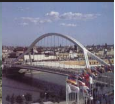
Fig. 82 - Ponte da Barqueta, projeto de Juan José Arenas e Marcos Pantaléon, que possui vão único possibilitando a utilização do trecho para regatas. (COHN, David; RUSSEL, James. Expo '92 Seville. Architectural Record, New York, v. 180, n. 8).
