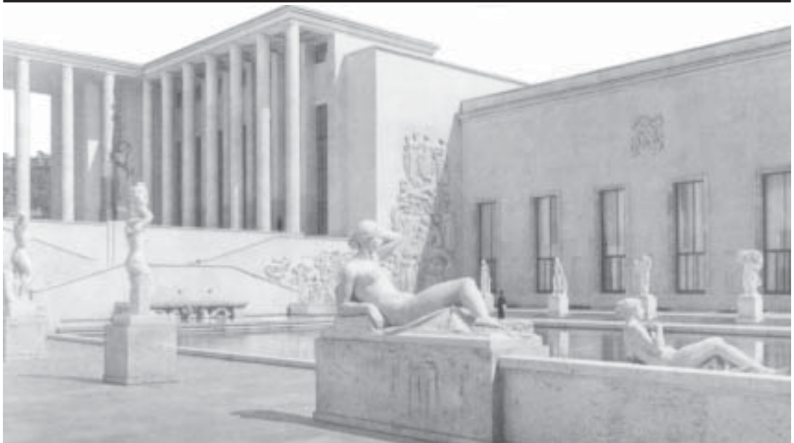
Fig. 62 - O palácio de Tóquio ou Museu de Arte Moderna, do Estado e da Cidade, configura-se como uma construção ambígua, tendendo ora ao classicismo e ora ao modernismo. (OLIVEIRA, Rosa Neves de. Paris 1937. Lisboa: Parque EXPO '98, 1998).
