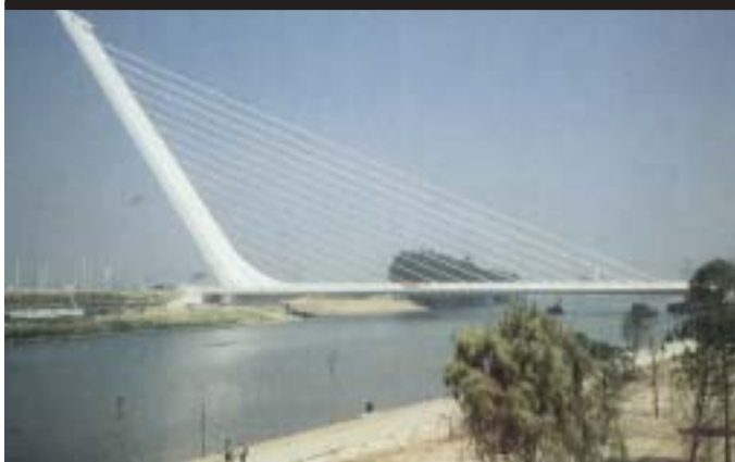
Fig. 81 - Ponte de Alamillo, projeto de Santiago Calatrava, cujo vão é sustentado por tirantes ligados a um único pilar, com forte efeito plástico. (DIXON, John Morris. World on a Platter. Progressive Architecture, Stamford, v. 7.92, jul 1992).
