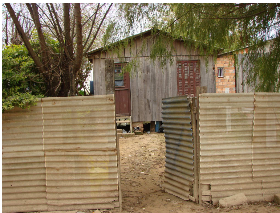
Foto 13 - Reaproveitando as telhas Fonte: Elaborada pela autora.
