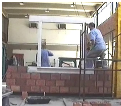
Figura 73: Encaixe da verga
