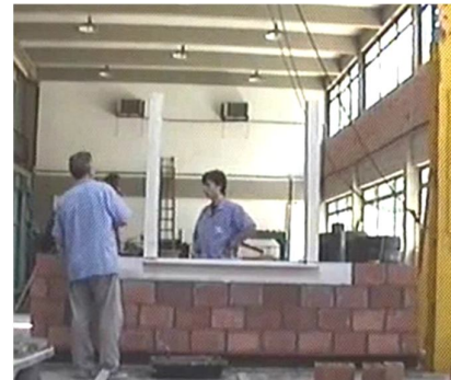
Figura 72: Montantes posicionados
