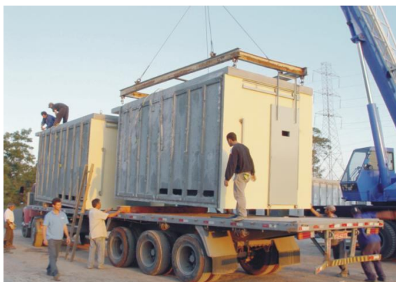
Figura 12: Exemplo de fabricação fora do local de construção
