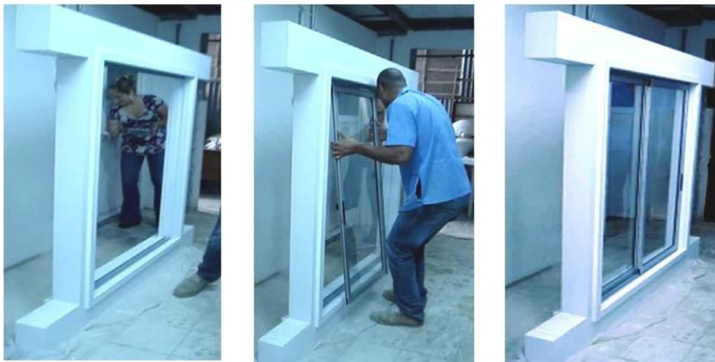
Figura 50: Sequência construtiva: a) EI, b) folhas móveis e c) conjunto finalizado
