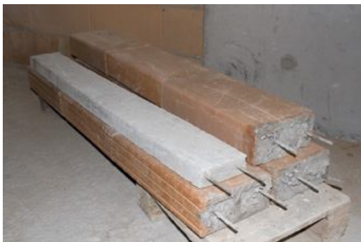
Figura 19: Verga e contraverga pré-moldadas.
