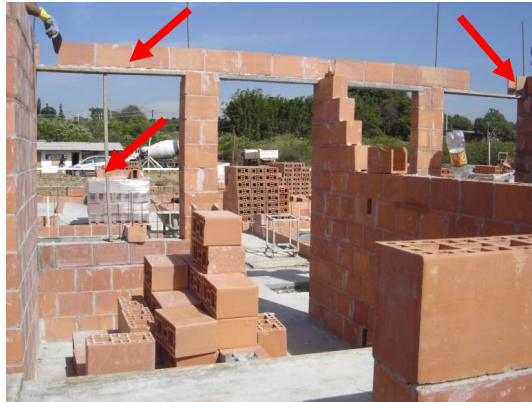
Figura 26: Execução da verga Fonte: POYASTRO (2008)
