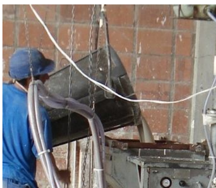
Figura 43: Matriz cimentícia fluida
