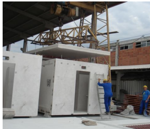
Figura 11: Exemplo de Pré-montagem
