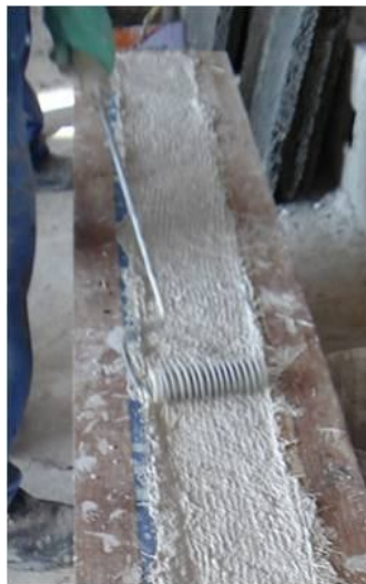
Figura 46: Compactação com rolo espiralado
