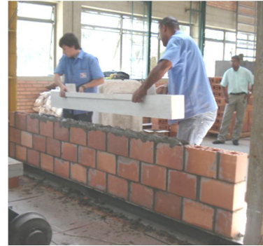
Figura 70: Assentamento da contraverga
