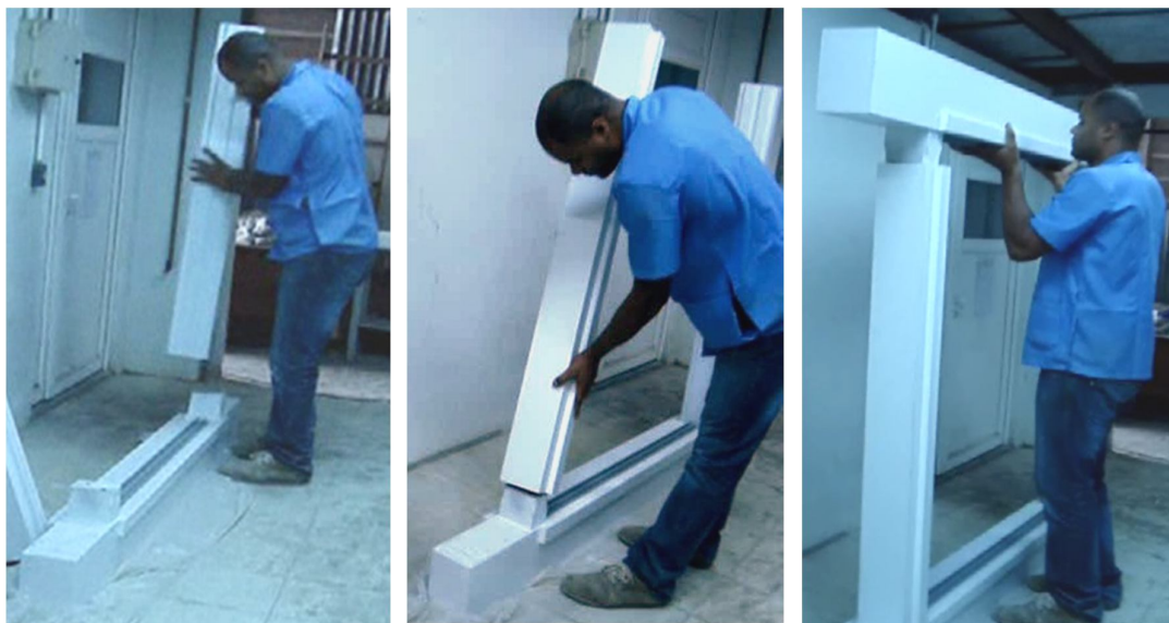
Figura 49: Sequência construtiva: a) contraverga, b) montantes e c) verga
