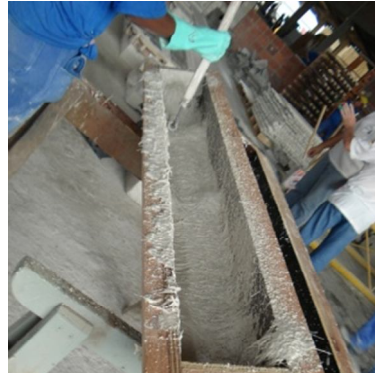
Figura 53: Material projetado e início da compactação.
