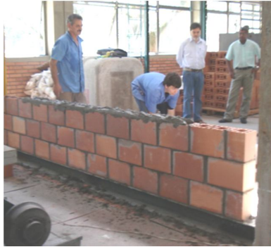
Figura 69: Execução das primeiras fiadas
