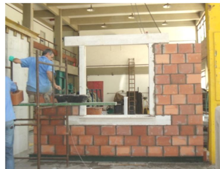
Figura 74: Execução da alvenaria
