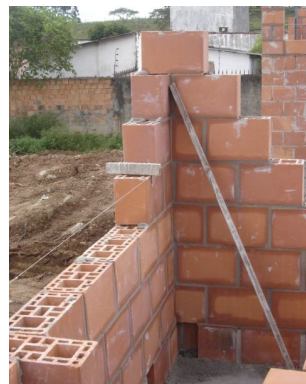
Figura 18: Amarração dos blocos.
