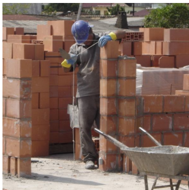
Figura 17: Verificação de prumo.
