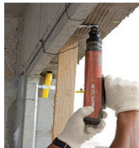
Figura 32: Fixação do contramarco.
