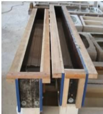
Figura 52: Fôrmas de madeira
