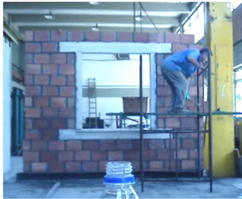
Figura 75: Etapa final da execução da alvenaria
