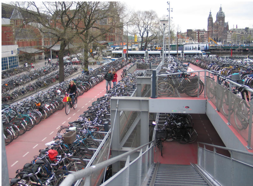
Figura 9 Estacionamento na Estação Central de Amsterdã
