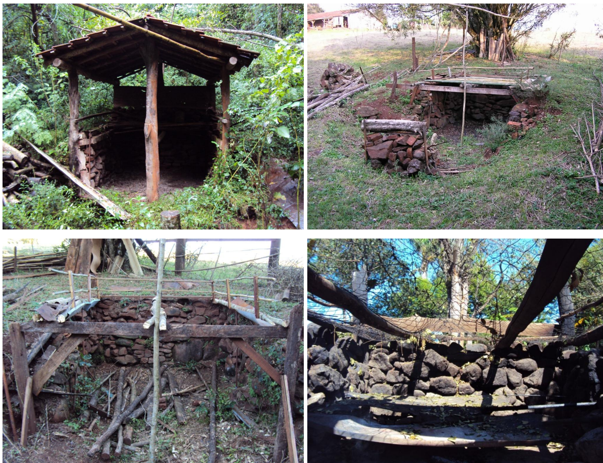
Figura 41 - Os diferentes tipos de cariyo. Da esquerda para a direita e do alto para baixo. A) Cariyo com telhado no interior da mata, Bozano, B) Cariyo e sapecador, na beira de curso d'água, Panambi. C) Detalhe do cariyo mostrado em B, com suas paredes internas preenchidas com pedras. D) Cariyo com estrado de madeira e tela, Santo Cristo. Ano 2010.
