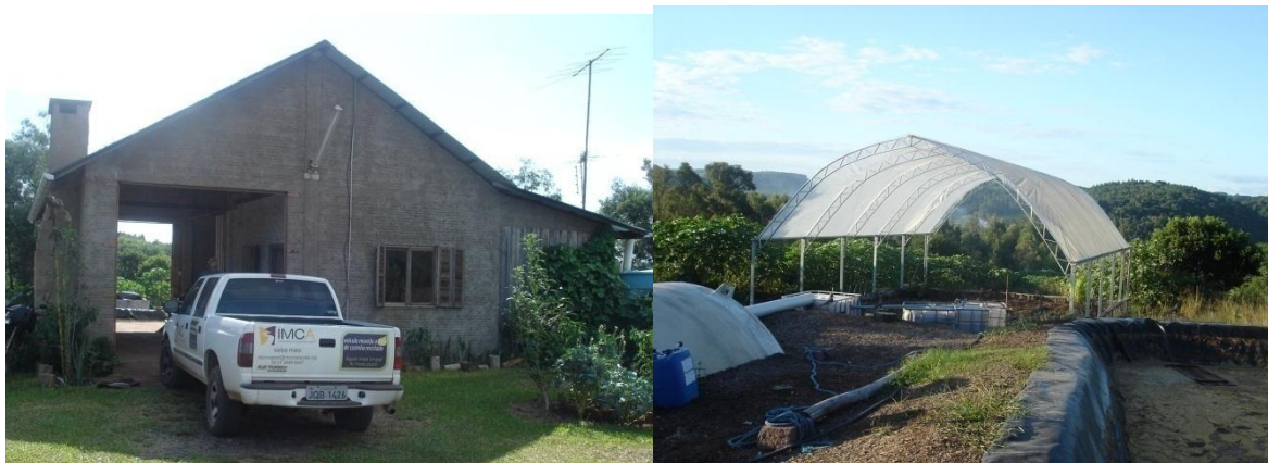
Figura 25 - Sede do IMCA, evidenciando a camionete movida a óleo de cozinha usado e a unidade de compostagem (foto obtida em abril de 2010, em Montenegro, RS).
