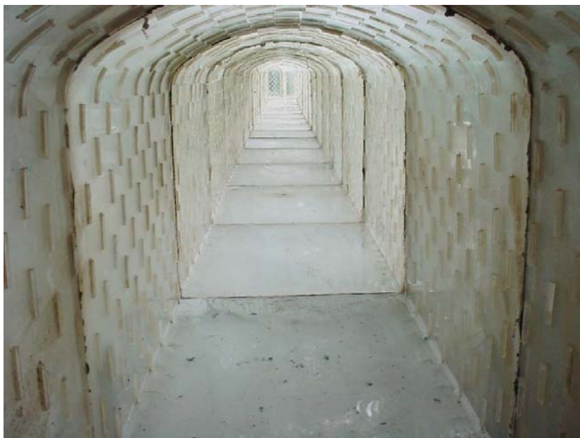
Figura 27 – Vista interna do túnel da estrutura do LAHE.
