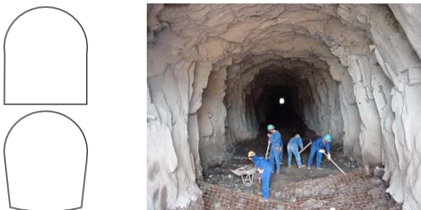
Figura 14 – Túnel seção ferradura, formas e exemplo.
