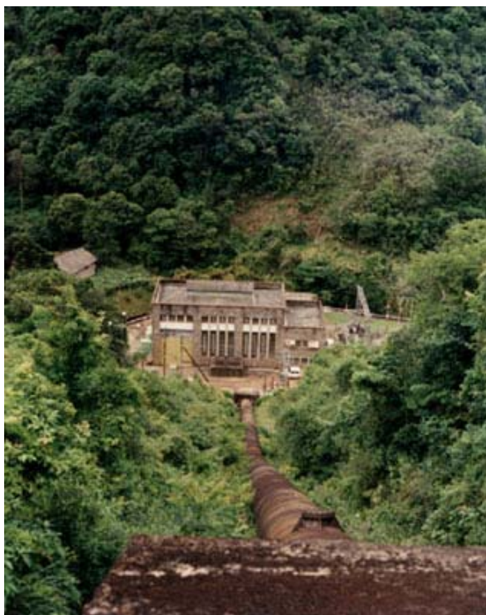
Figura 32 – Foto da Usina Hidrelétrica Bugres.
