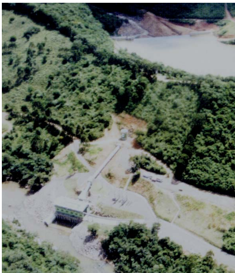
Figura 30 – Usina Hidrelétrica de Salto Forqueta.
