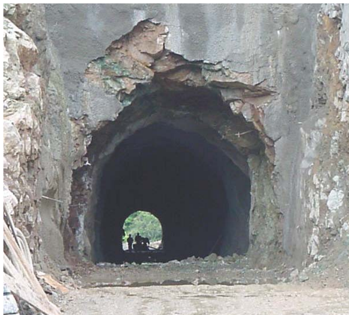
Figura 31 – Túnel escavado em rocha da Usina Hidrelétrica Salto Forqueta.
