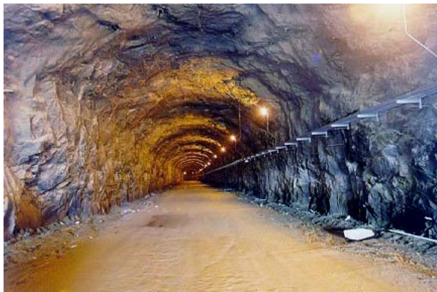
Figura 24 – Túnel de acesso da UHE de Serra da Mesa, similar ao túnel adutor.
