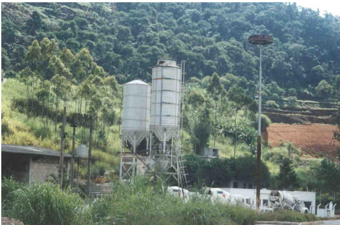
**Figura 1.1** Vista parcial de uma concreteira na região de Juiz de Fora, podendo-se notar a presença de dois silos de aglomerantes, um de CPV ARI RS e outro de escória de alto-forno
