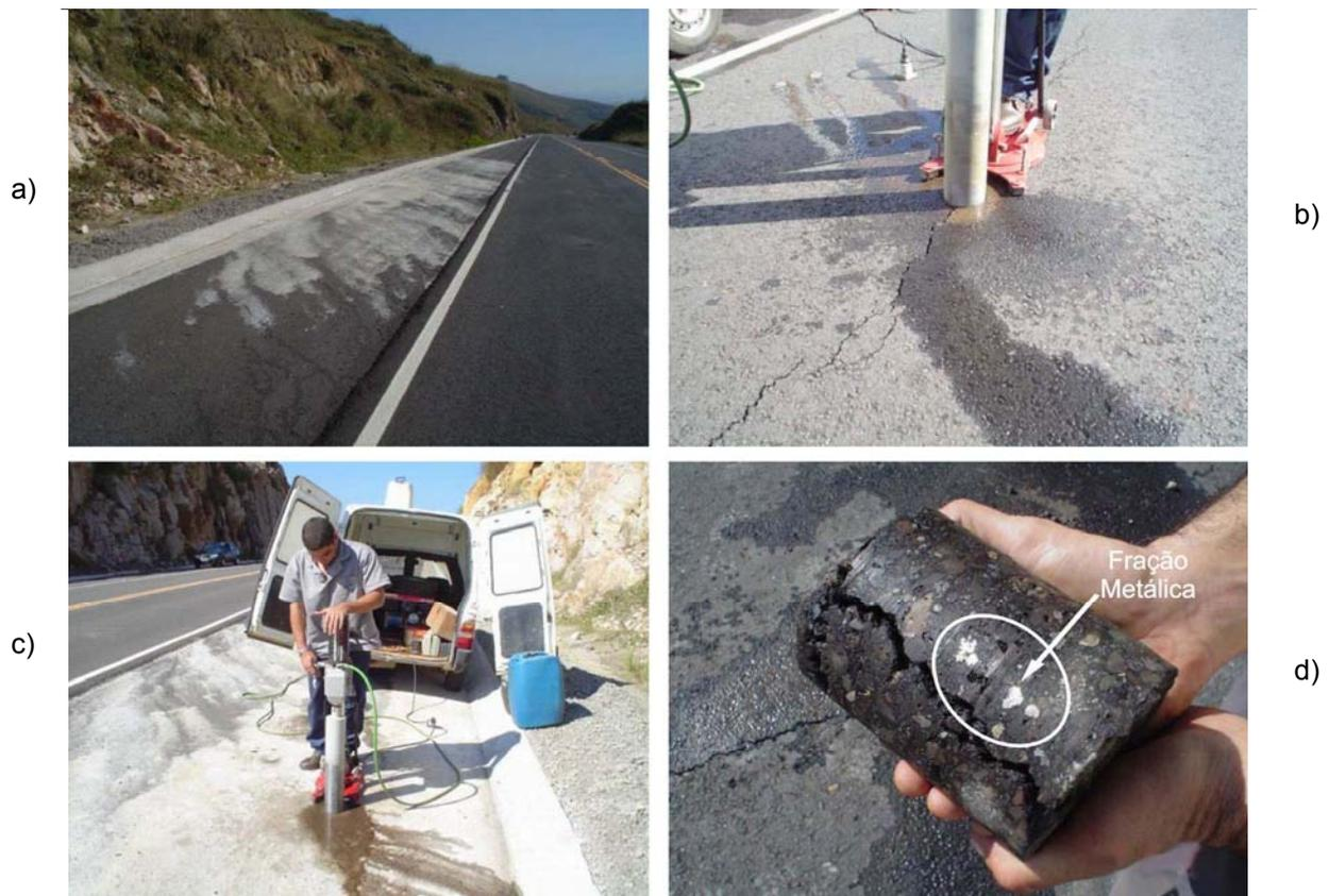
**Figura 2.13** Rodovia no estado do Rio de Janeiro – RJ executada com a base em escória de aciaria LD: a) detalhe do depósito de carbonato de cálcio; b) fissura no revestimento asfáltico; c) extração de testemunhos do revestimento asfáltico e d) testemunho apresentando o detalhe da fração metálica da escória LD e a trinca do testemunho extraído do revestimento asfáltico
