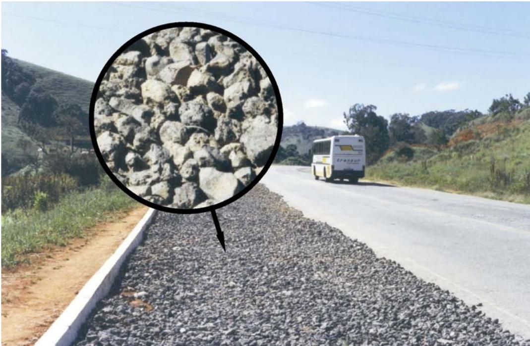
**Figura 2.7** Utilização da escória de aciaria elétrica da BMP Siderúrgica S.A. próximo à cidade de Juiz de Fora – MG.
