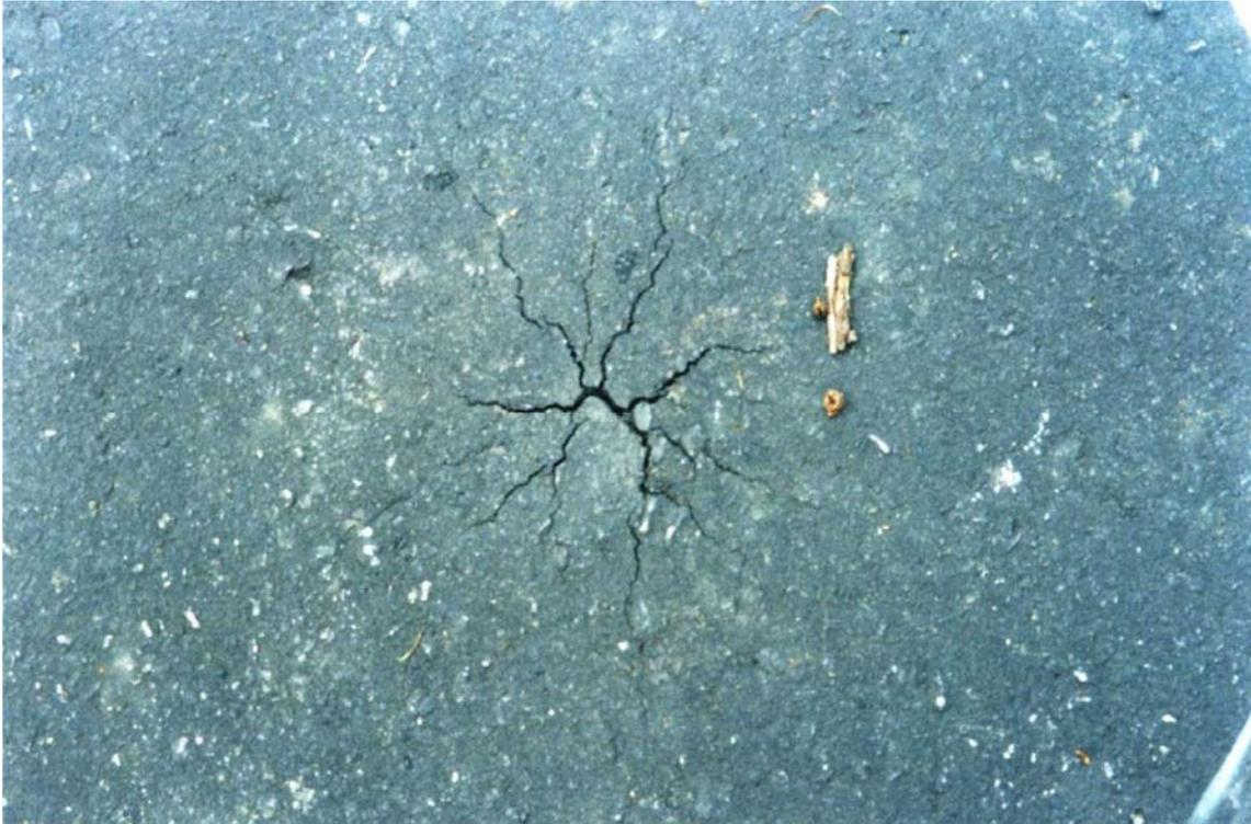
**Figura 2.11** Manifestação patológica em pavimento asfáltico (“vulcãozinho”) causado pela expansibilidade do uso de escória de aciaria (Acesso Norte em Juiz de Fora – MG).
