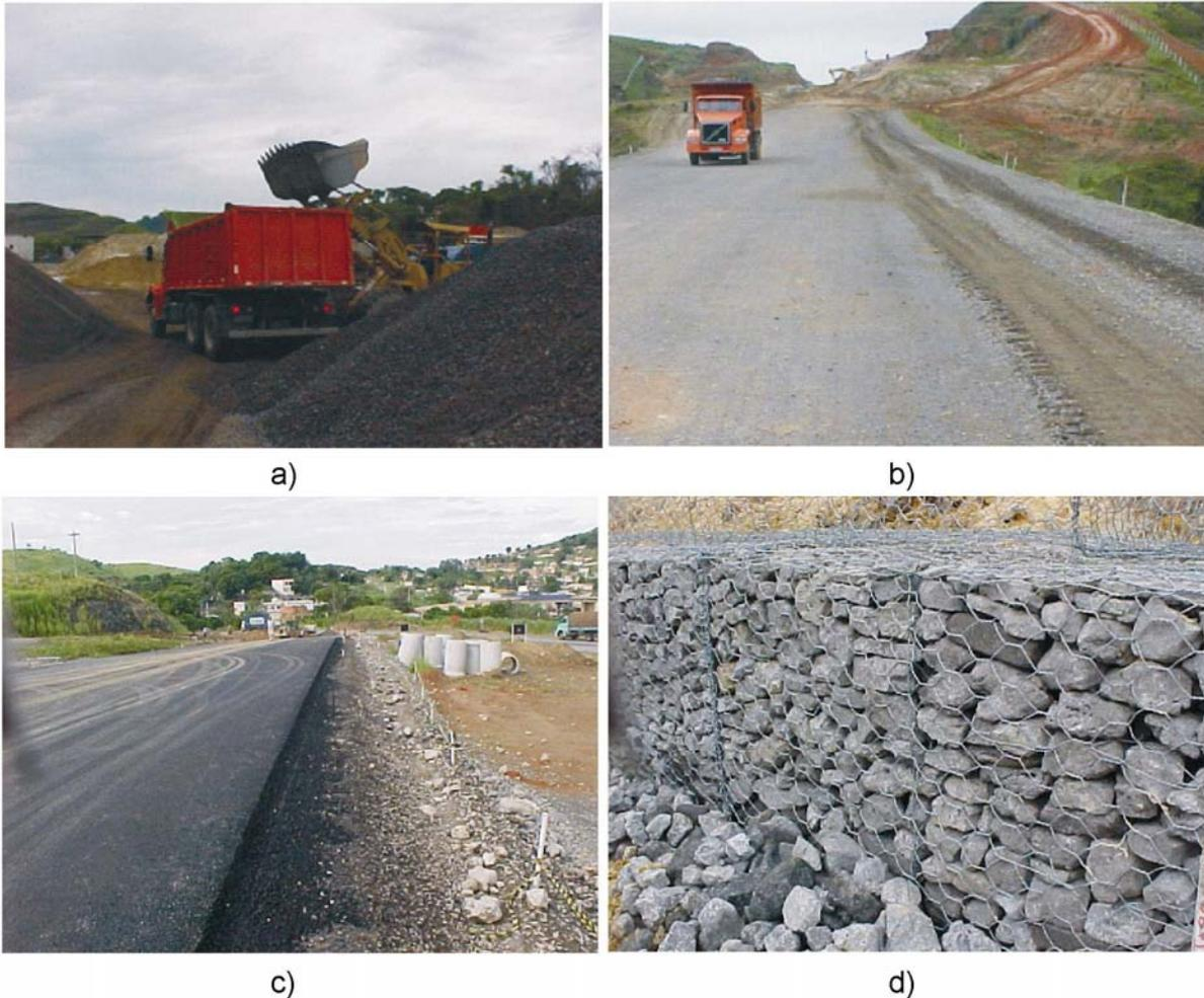
**Figura 1.2** Construção do contorno da cidade de Volta Redonda – RJ utilizando-se escória de aciaria gerada na Companhia Siderúrgica Nacional (CSN): a) carregamento da escória após peneiramento; b) transporte da escória para ser utilizada como base; c) revestimento em CBUQ (concreto betuminoso usinado a quente) executado com escória e d) execução de contenção em gabião utilizando-se escória
