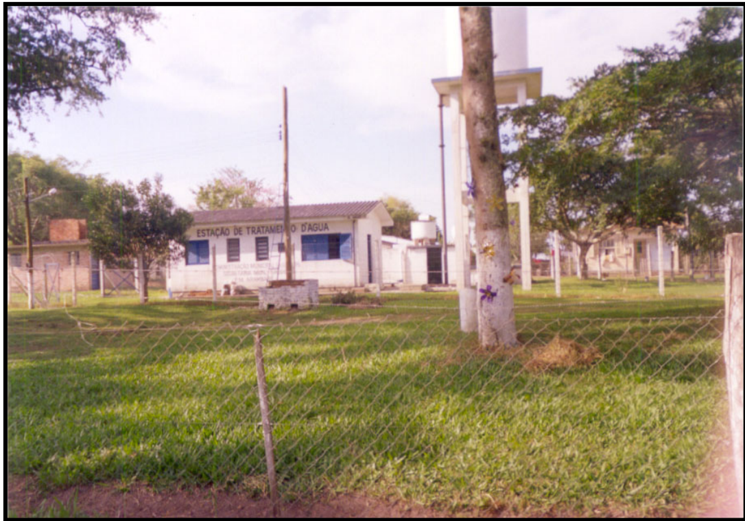
FOTOGRAFIA 5 - Estação de tratamento de Água – Santa Rita do Sul
