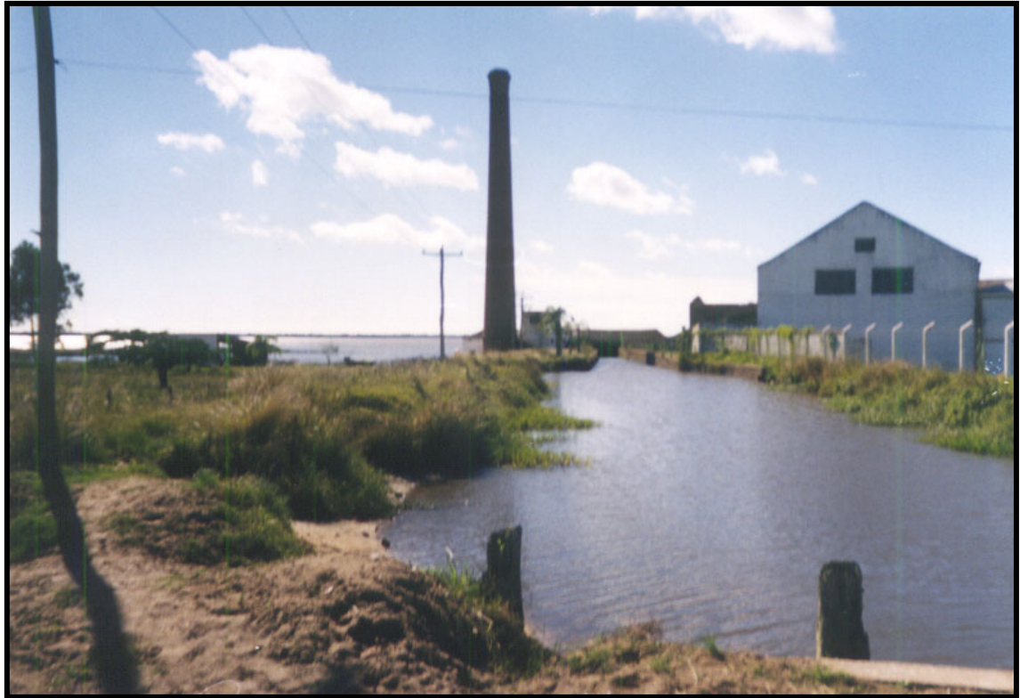
FOTOGRAFIA 3 - Canal de irrigação (ao fundo a Lagoa Guaraxaim) – Santa Rita do Sul
