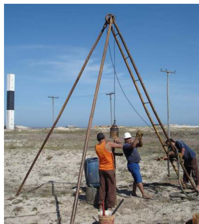
Fig.06 - Execução da sondagem SPT.
