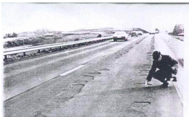
Figura 2.2 – descamação devido à baixa estabilidade Marshall
