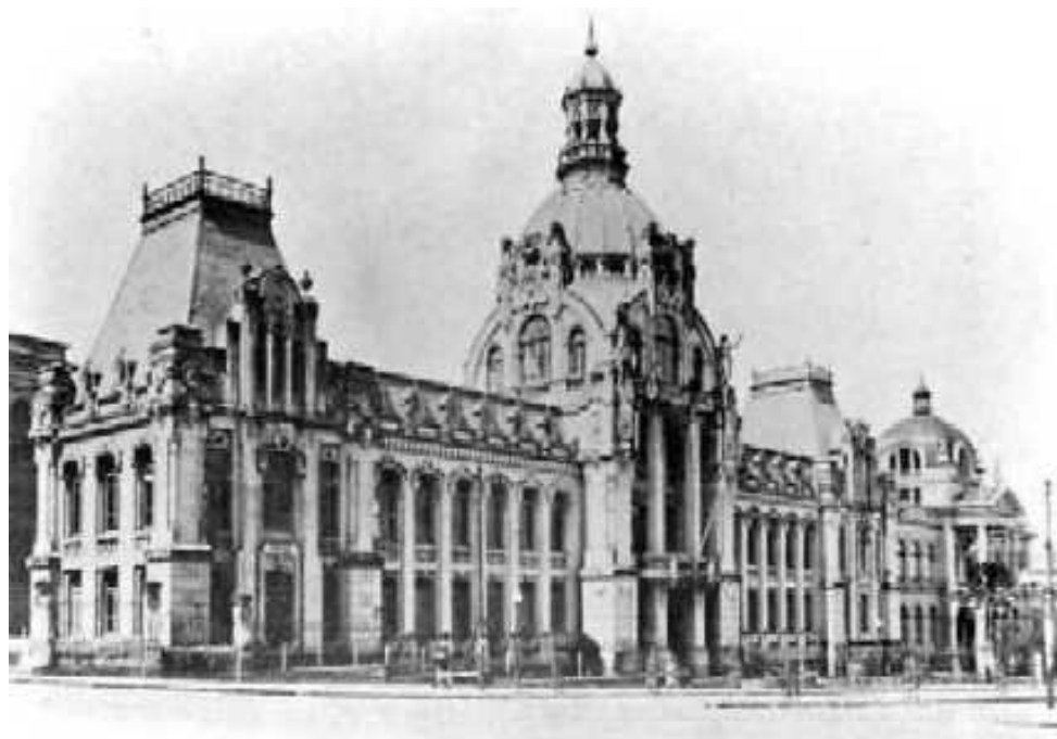
Figura 16- Ginásio Júlio de Castilhos ao lado do prédio da Faculdade de Direito. Fonte: Foto de um dos Relatórios da Escola de Engenharia (1911), UFRGS.
