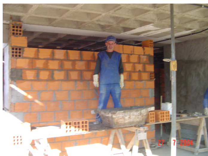
Figura 15– Elevação alvenaria usando andaime
