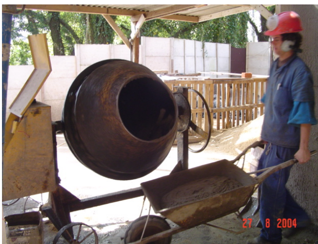
Figura 20 – Posto de produção de argamassa – Betoneira
