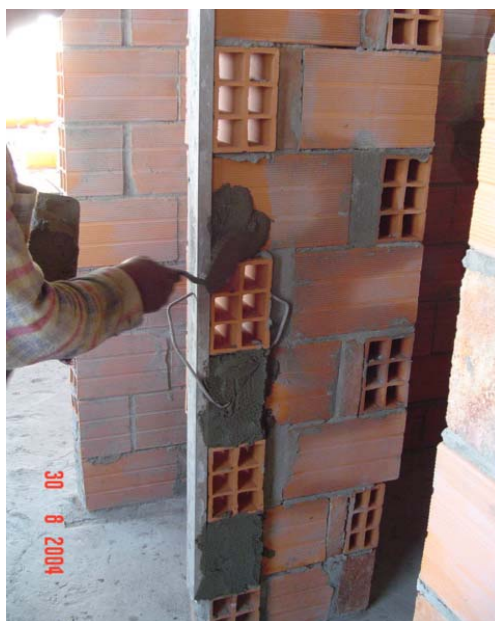
Figura 32 – Preenchimento dos furos dos blocos com argamassa
