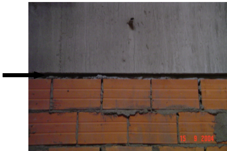
Figura 17 – Encunhamento interno
