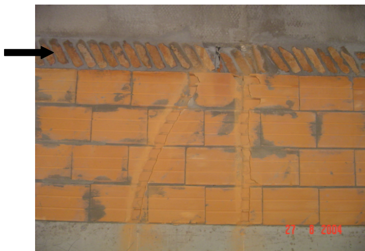
Figura 16 – Encunhamento externo
