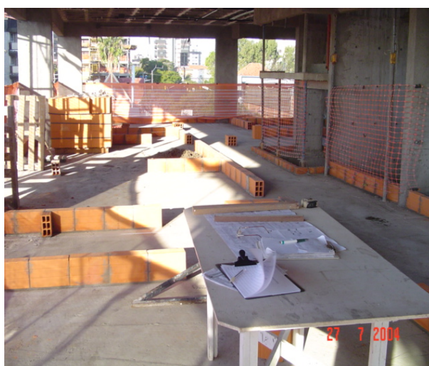
Figura 13 – Demarcação alvenaria
