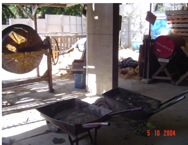
Figura 31 – Carrinho com argamassa
