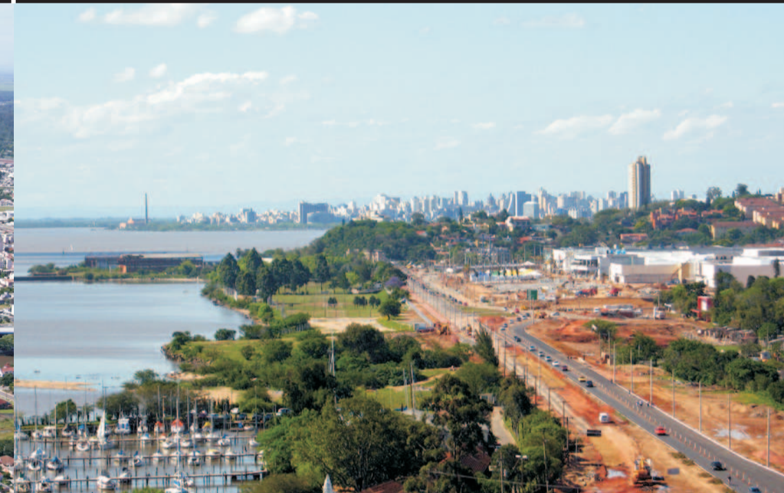
Vista da duplicação da Avenida Diário de Notícias e da construção do Barrashoppingsul em Porto Alegre
