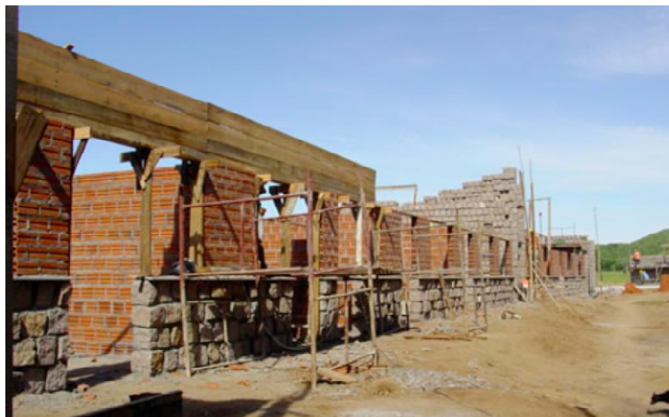
Figura 28. Foto das paredes externas e internas na construção da escola Frei Pacífico.
