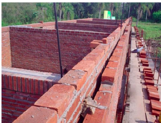
Figura 42. Execução das paredes externas e internas em execução
