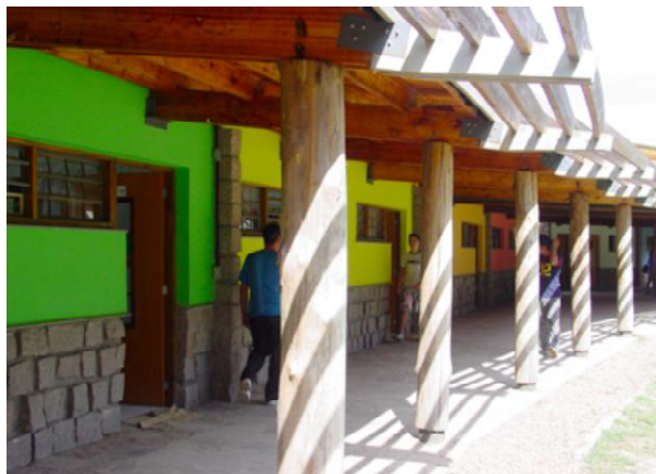
Figura 31. Foto da cobertura e circulação externa da edificação. Escola Frei Pacífico.
