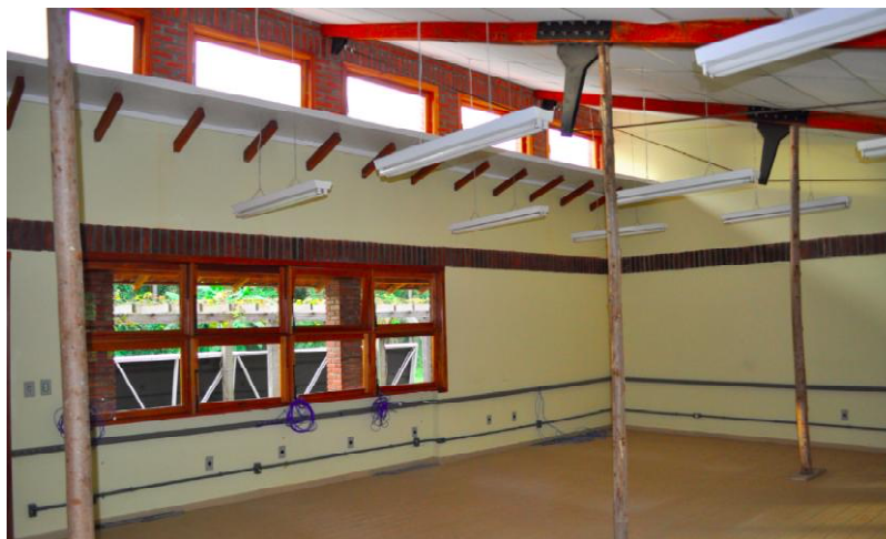
Figura 49. Janelas inferiores e superiores, na fachada norte, em uma das salas
