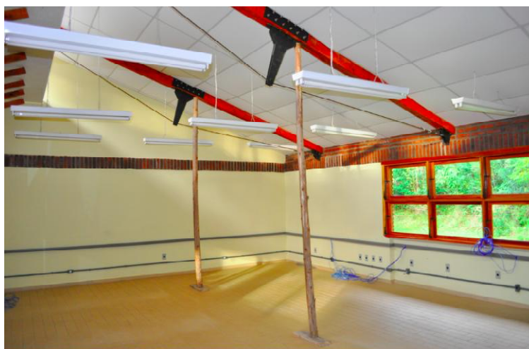
Figura 46. Escoramento temporário do telhado sul
