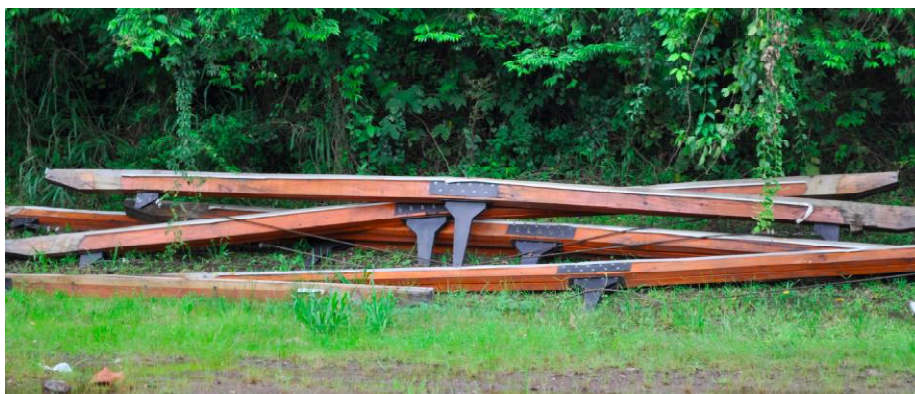
Figura 51. Vigas de eucalipto, depois de serem desmontadas
