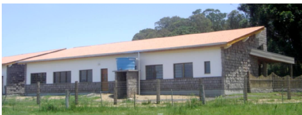
Figura 29. Foto do lado sul da edificação, escola Frei Pacífico.
