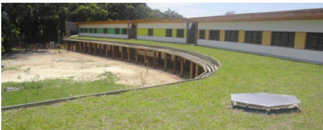
Figura 30. Lado norte da edificação, cobertura verde externa e janelas superiores das salas de aula. Escola Frei Pacífico.
