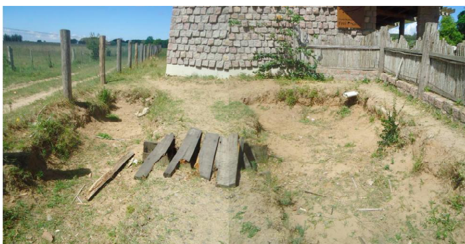
Figura 38. Estado atual da lagoa de estabilização.
