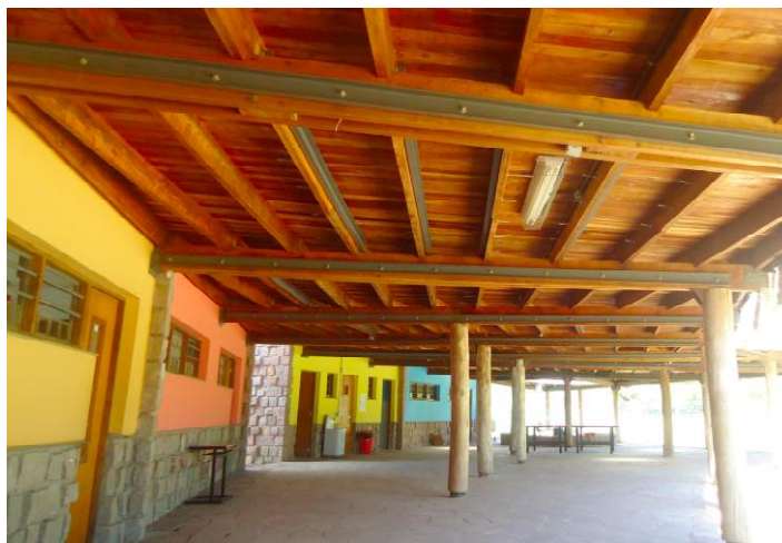
Figura 36. Reforço metálico na estrutura da cobertura verde, Escola Frei Pacífico
