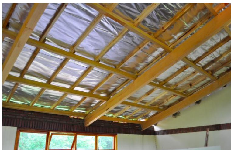
Figura 52. Novas vigas de madeira maciça
