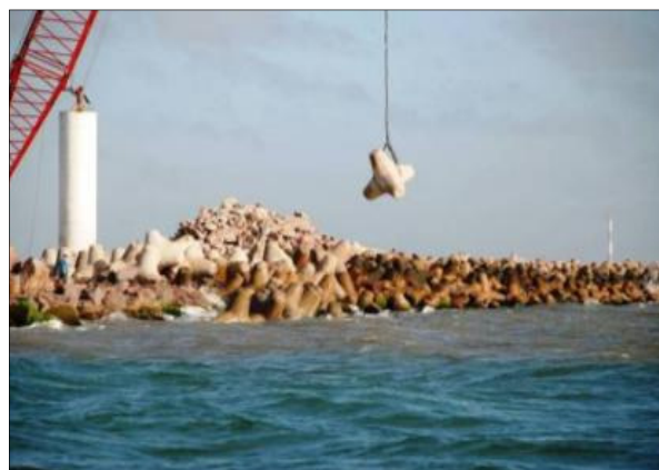
Figura 19: lançamentos de tetrápodes com o guindaste
