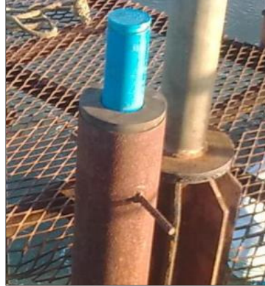
Figura 57: tubo flexível instalado
