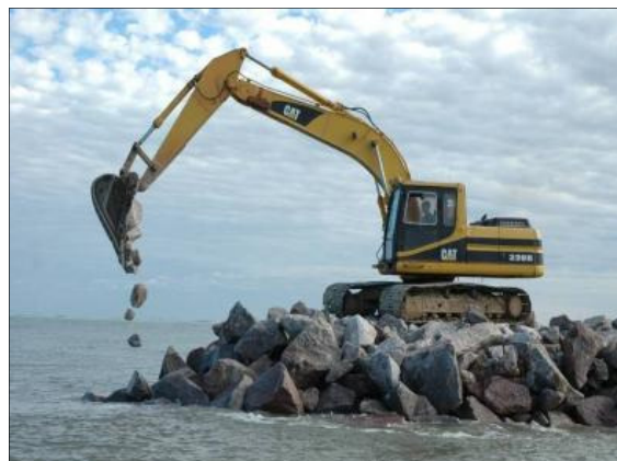
Figura 17: lançamentos de subcarapaça com a escavadeira
