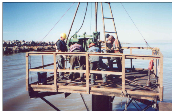
Figura 21: execução dos ensaios de campo sobre plataforma (CONSÓRCIO CBPO, PEDRASUL, CARIOCA E IVAÍ, 2001)
