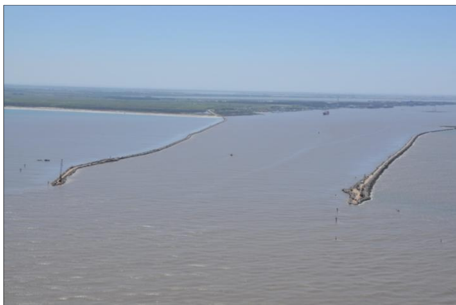
Figura 13: vista aérea da obra de ampliação dos Molhes Leste e Oeste (CONSÓRCIO CBPO, PEDRASUL, CARIOCA E IVAÍ, 2001)
