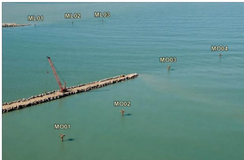
Figura 45: foto aérea com a visão geral das estações de monitoramento (CONSÓRCIO CBPO, PEDRASUL, CARIOCA E IVAÍ, 2009)
