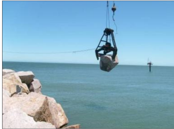
Figura 18: lançamentos de carapaça de enrocamento com o guindaste
