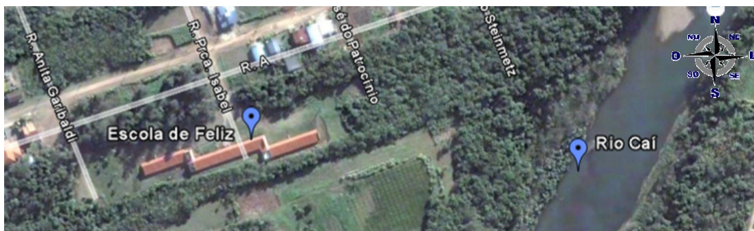
Figura 11: Vista aérea da edificação escolar. (Fonte: Adaptado de Google Maps)
