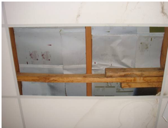
Figura 19: Detalhe da utilização de chapas de alumínio (offset) entre o forro e as telhas.
