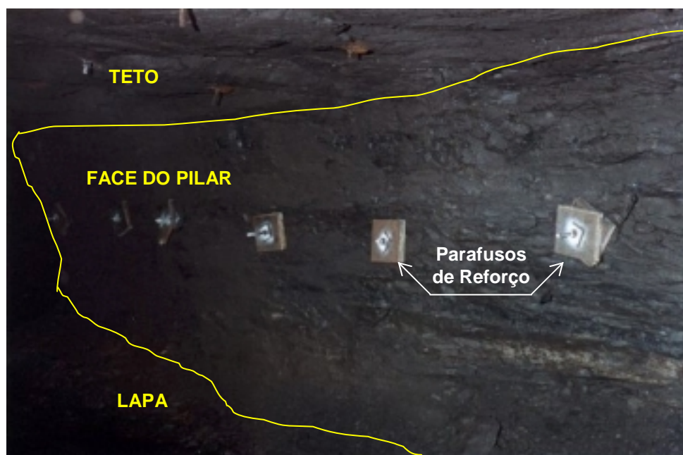
Figura 3.3 – Pilar com Reforço da Mina Esperança.
