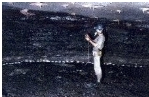
Operação 4: Desmonte com emprego de explosivo.
