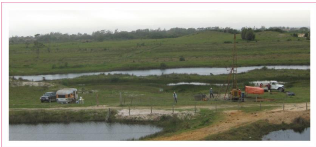
Figura 8. Acompanhamento da perfuração do poço MML -09 no município de Maracajá (SC).
