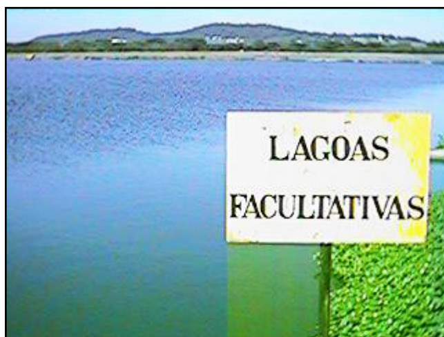
Figura 5.21 Ponto de coleta dos esgotos
