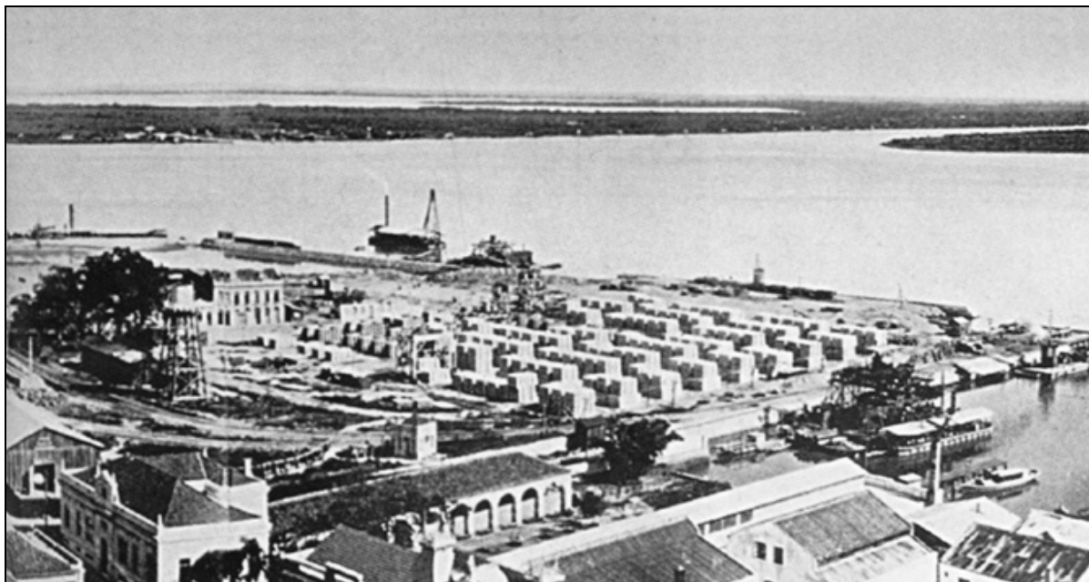
Fig. 26: Oficina de blocos de concreto para a construção do muro do cais. Praça Martins de Lima. Fonte: acervo GEDURB
