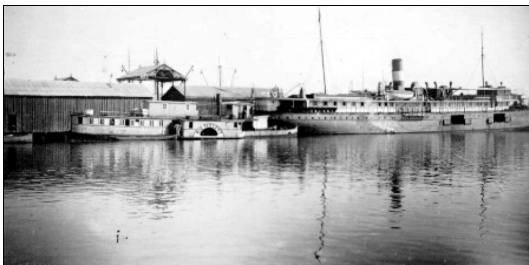
Fig. 14: Antigo local de desembarque de passageiros no cais do porto com os antigos armazéns de madeira. Fonte: arquivo GEDURB
