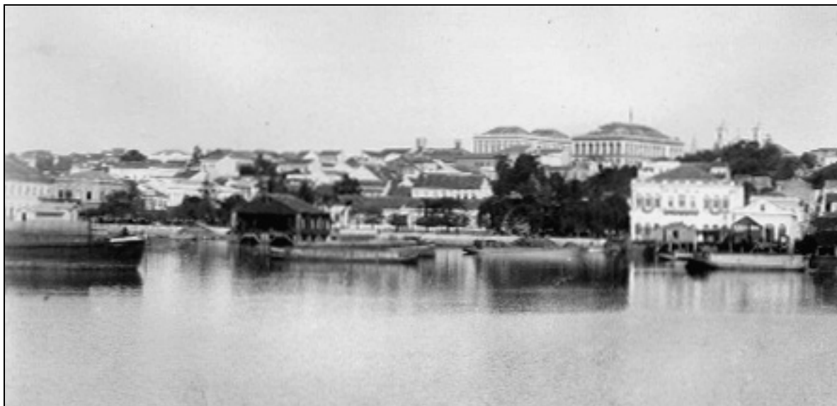
Fig. 9: Vista do rio em direção à Praça da Alfândega, antes do início das obras do porto. O contato da cidade com o rio ainda se dava diretamente. Fonte: arquivo GEDURB
