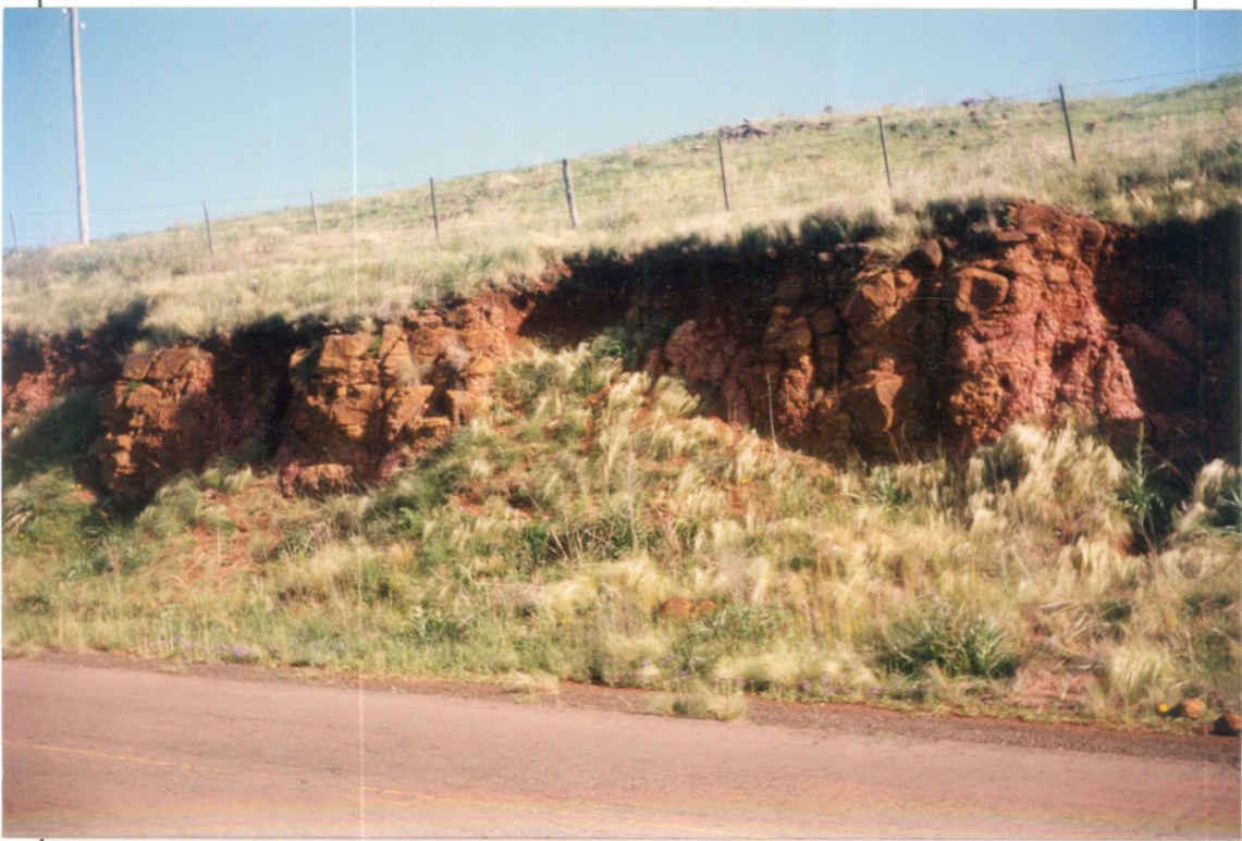
FOTO 3. A superfície topográfica corta diretamente o alterito, situados nos morros de topo plano.
