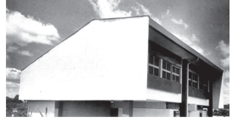
Casa Baeta, Vilanova Artigas, 1956. In ARTIGAS (1997, p. 73)
