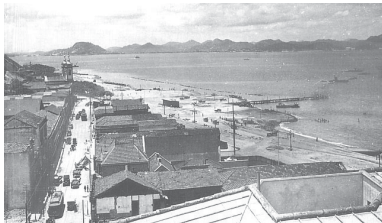
Igreja Sta. Luzia, RJ, 1872. In www.almacarioca.com.br
