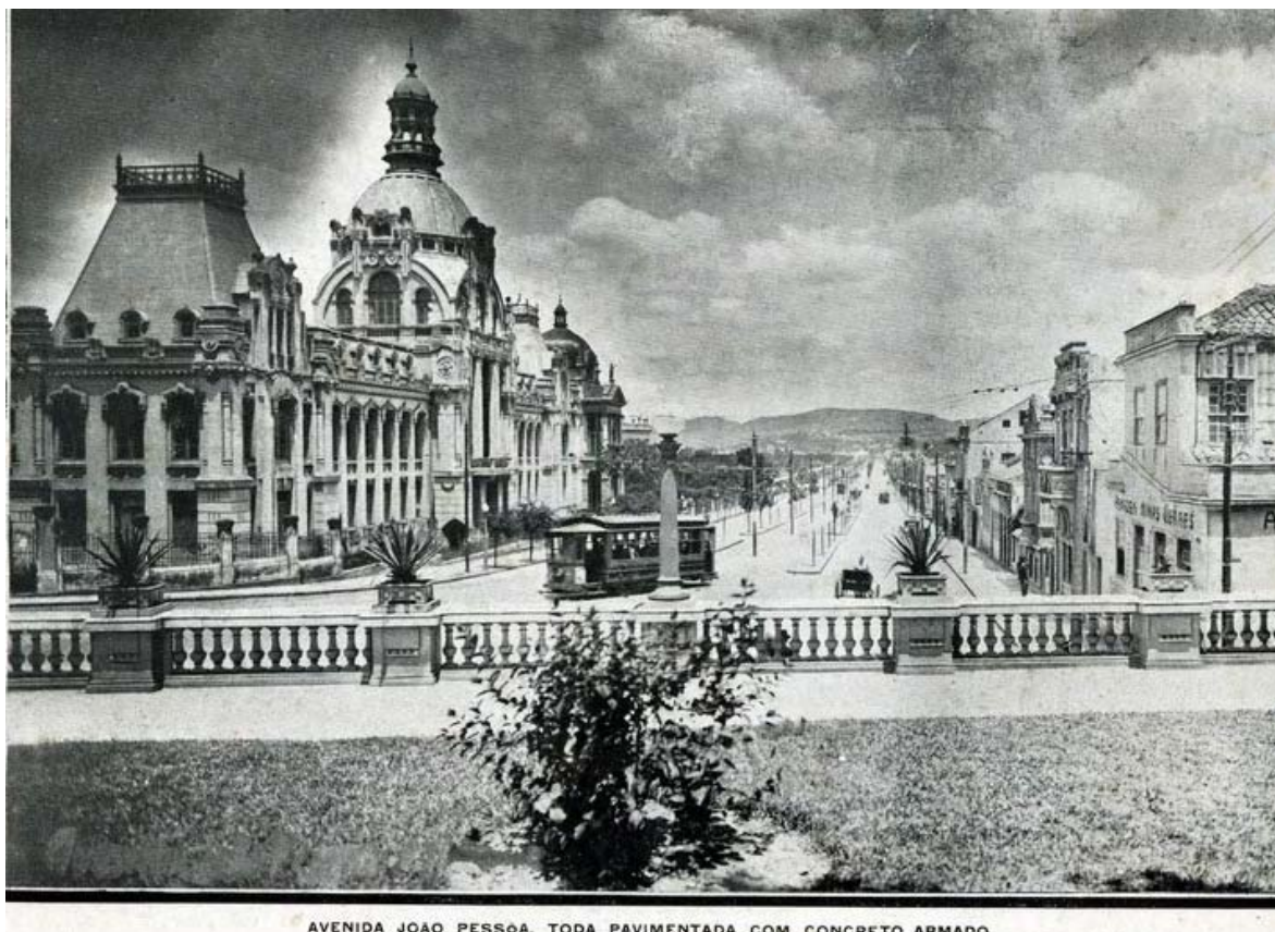
Fotografia 154– Avenida João Pessoa, toda pavimentada com concreto armado. (legenda original).
