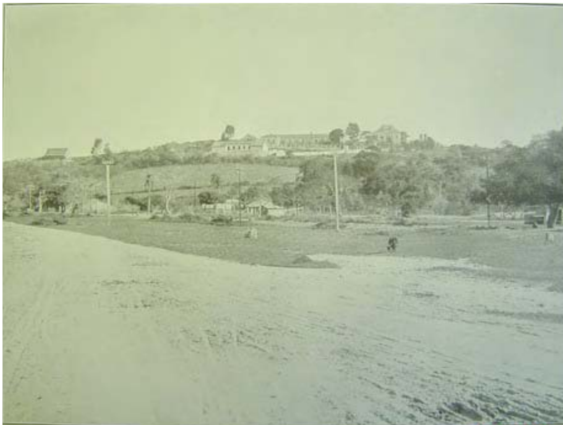
Fotografia 20 – Hospital Brigada Militar do Estado (título original). Vista geral (legenda original). Fonte: ESTADO DO RIO GRANDE DO SUL. [Secretaria de Obras Públicas]. Obras públicas : centenário da Independência. Porto Alegre: Oficinas Graphics d'A Federação, 1922. Acervo: AHRGS.
