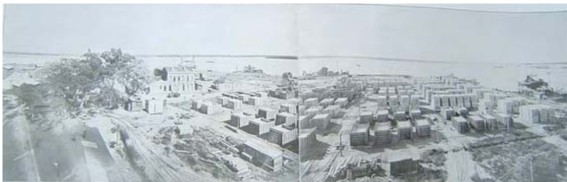
Fotografia 1 – Obras do Porto de Porto Alegre (título original). Vista geral do estaleiro de fabricação de blocos (legenda original).
