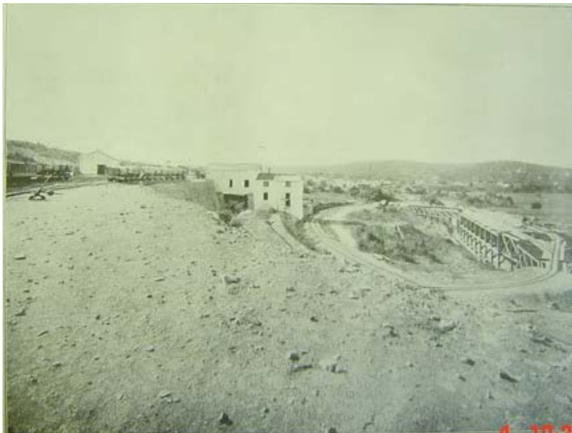
Fotografia 12 – Obras do Porto de Porto Alegre. Pedreira do Pontal do Dionísio (título original). Vista da instalação para britar pedra (legenda original).
