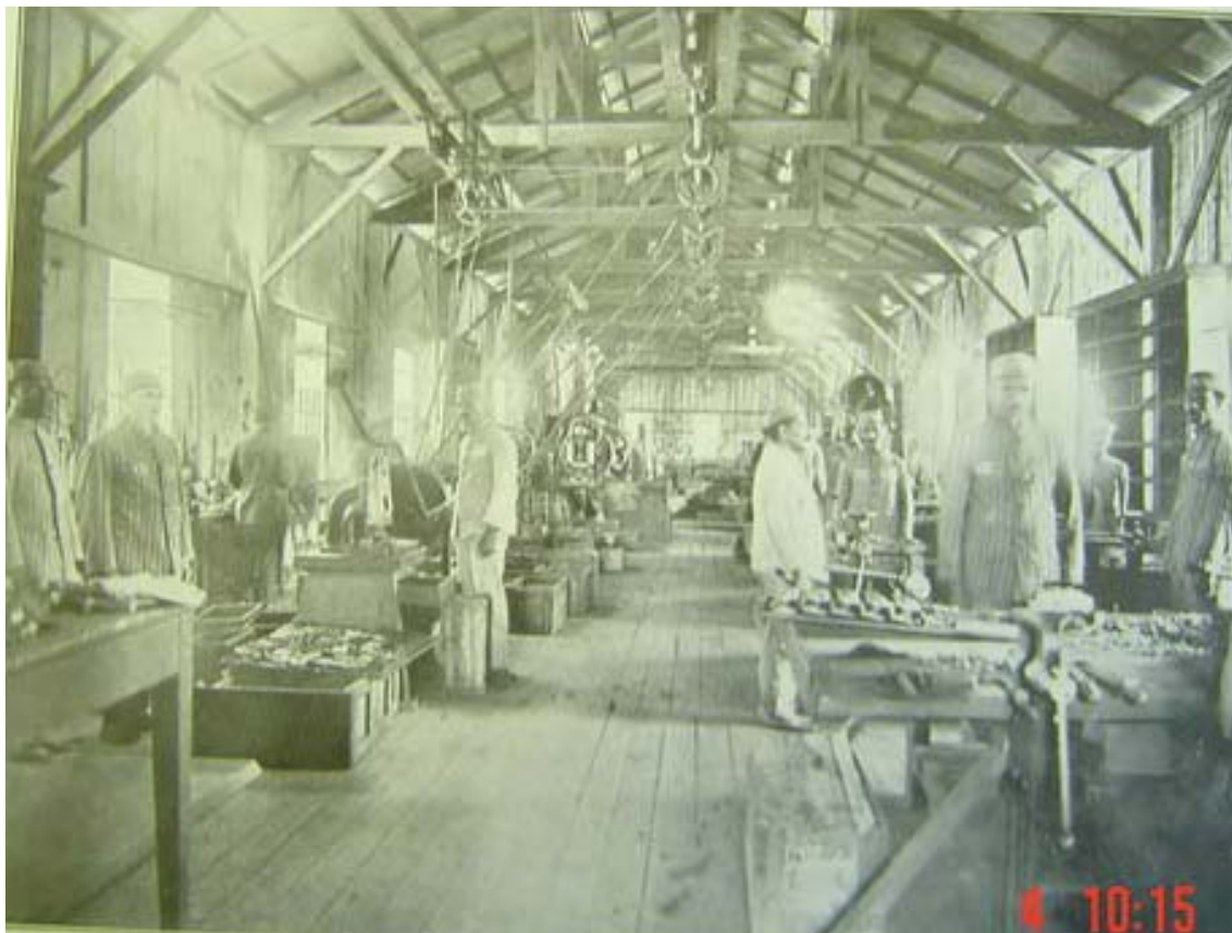
Fotografia 18 – Casa de Correção (título original). Oficinas de Serralheria (legenda original). Fonte: ESTADO DO RIO GRANDE DO SUL. [Secretaria de Obras Públicas]. Obras públicas: centenário da Independência . Porto Alegre: Oficinas Graphicas d'A Federação, 1922. Acervo: AHRGS.
