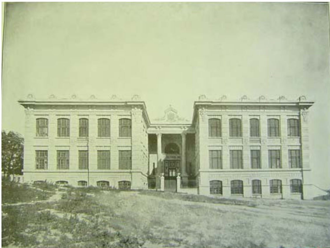
Fotografia 9 – Colégio Elementar “Fernando Gomes” em Porto Alegre (título original). Projeto da secretaria de Obras Públicas (legenda original).
