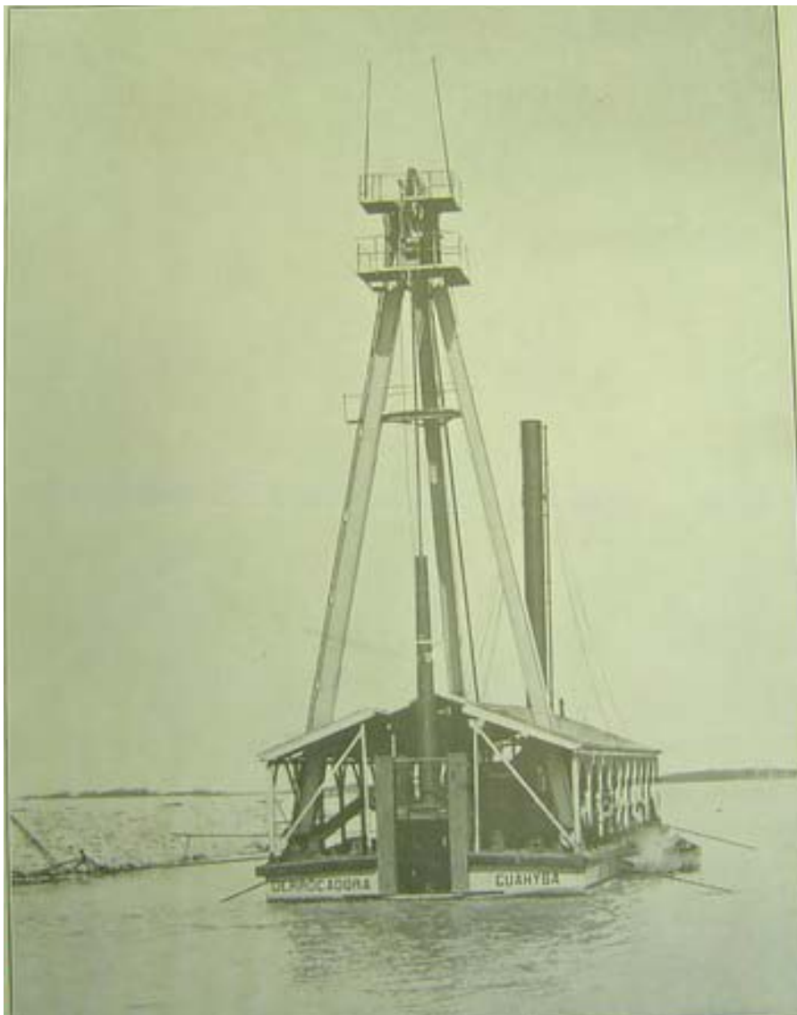
Fotografia 2 – Obras do Porto de Porto Alegre - Derrocadora “Guahyba” (título original). Aparelho empregado na abertura da cava de fundação na parte da rocha (legenda original). Fonte: ESTADO DO RIO GRANDE DO SUL. [Secretaria de Obras Públicas]. Obras públicas: centenário da Independência . Porto Alegre: Oficinas Graphicas d’A Federação, 1922. Acervo: AHRGS.
