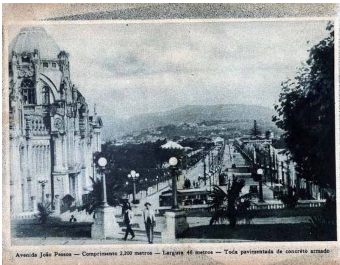
Fotografia 40 – Avenida João Pessoa – Comprimento 2.200 metros – Largura 46 metros – Toda pavimentada de concreto armado. (legenda original).
