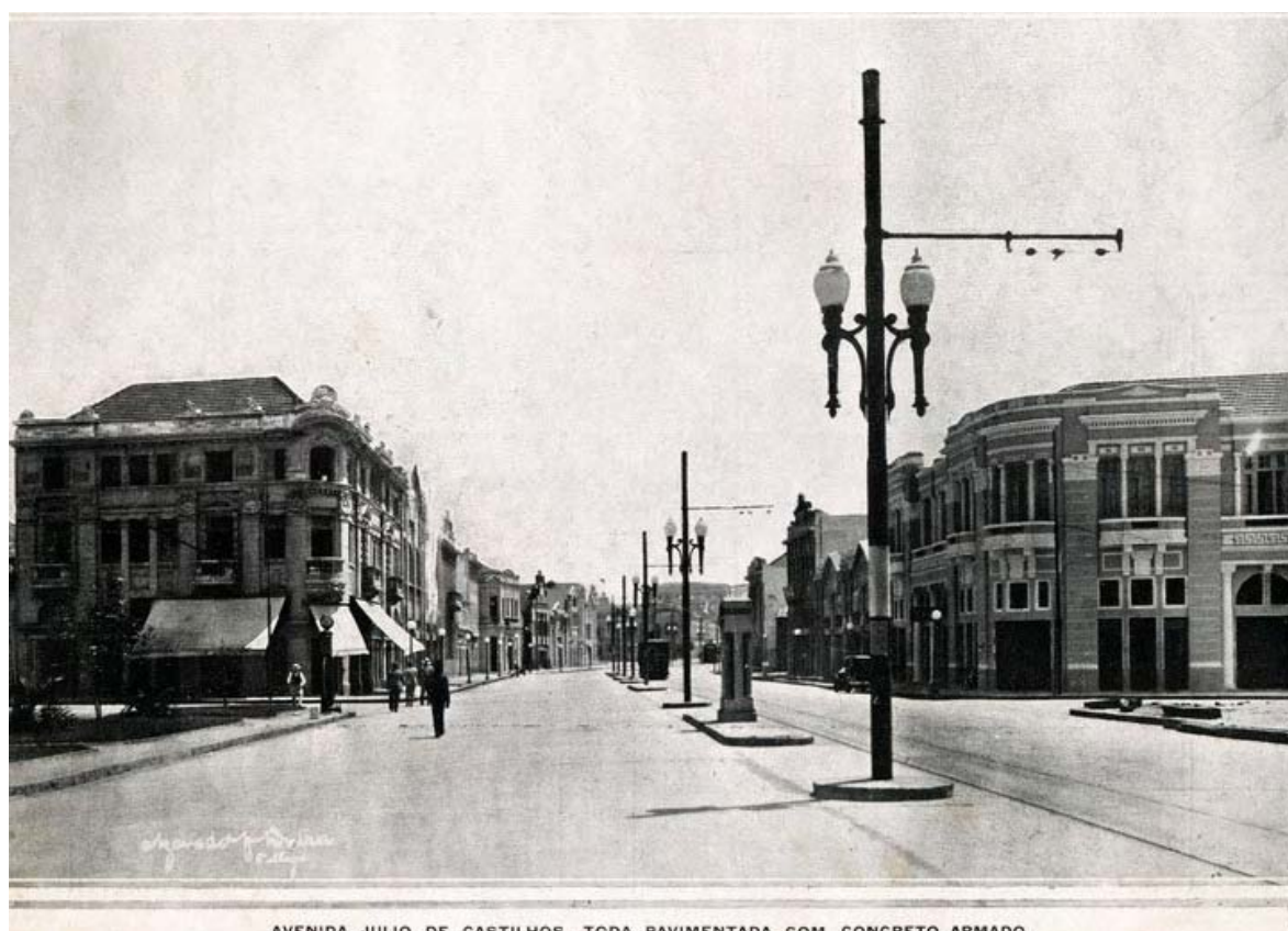
Fotografia 156 – Avenida Júlio de Castilhos, toda pavimentada com concreto armado. (legenda original).
