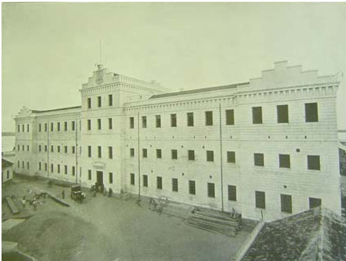
Fotografia 15 – Casa de Correção (título original). Vista geral (legenda original). Fonte: ESTADO DO RIO GRANDE DO SUL. [Secretaria de Obras Públicas]. Obras públicas : centenário da Independência. Porto Alegre: Oficinas Graphicas d'A Federação, 1922. Acervo: AHRGS.
