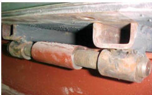
Figura 3.6 – Detalhe da dobradiça de ligação da rampa à estrutura.
