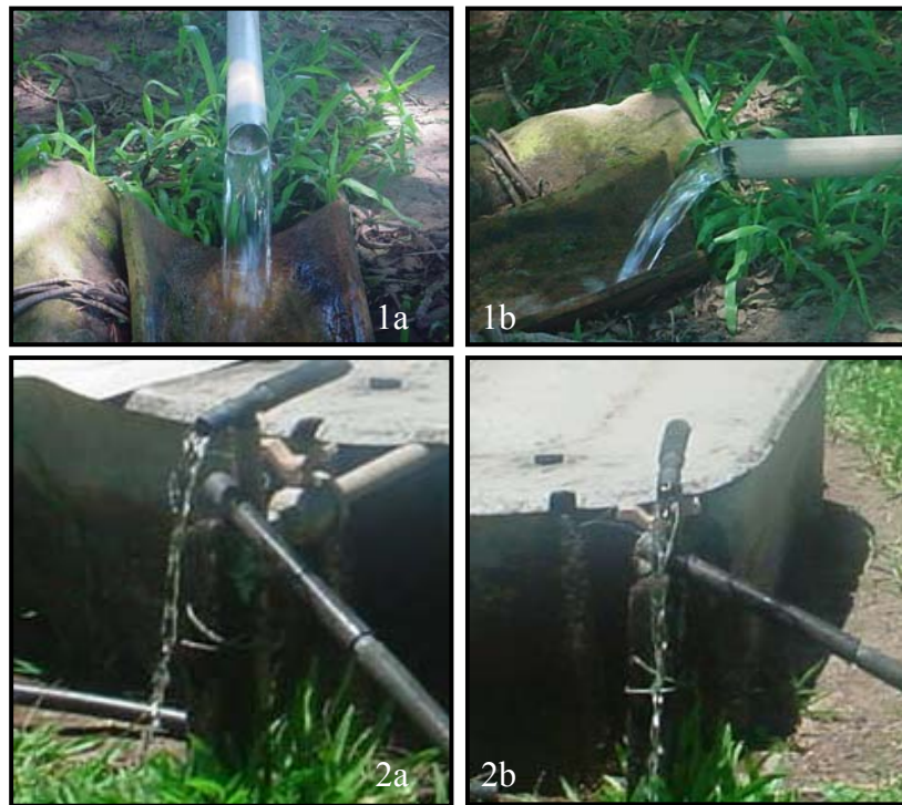
Figura 4.11: Vazão excedente das caixas d'água.
