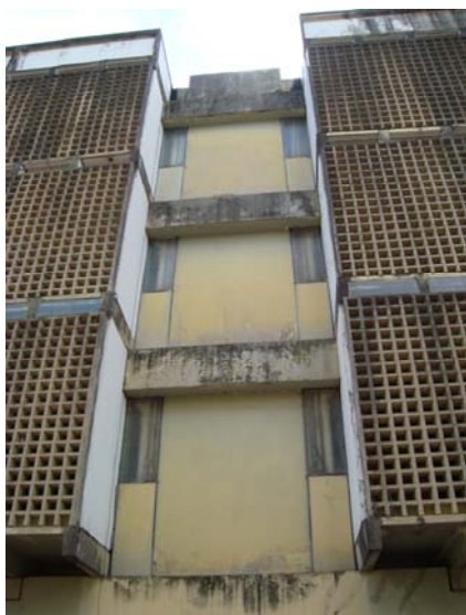
Fig. 50: Cobogós, fachada oeste
