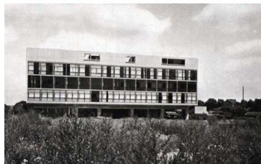
Fig. 36: Pavilhão Suíço, fachada sul.
