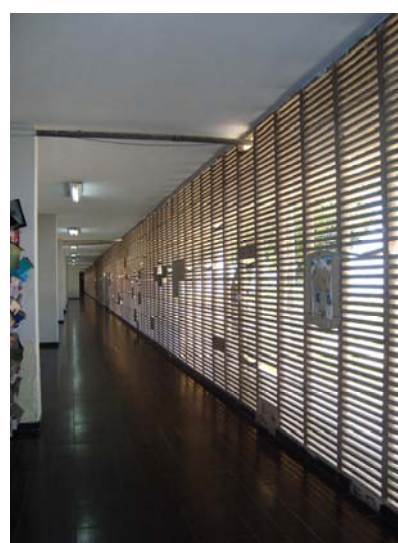
Fig. 47: Cobogós, fachada noroeste bloco A, 2011.
