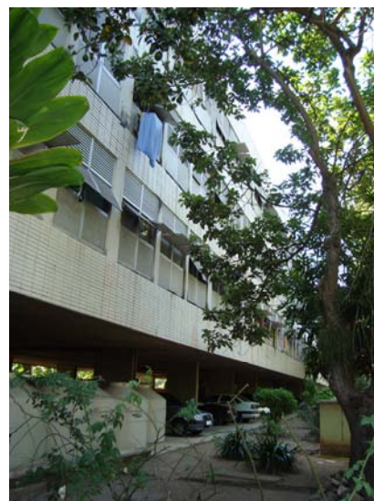
Fig. 45: Pilotis bloco B, 2011.
