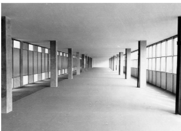
Fig. 88: CRUSP, pavilhão sem a compartimentação interna.
