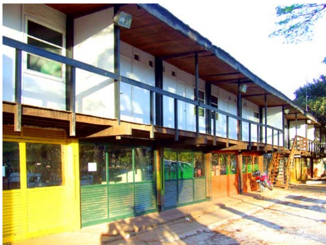
Fig. 24: Alojamentos pré-fabricados em madeira (OCA), Sérgio Rodrigues, 1962.
