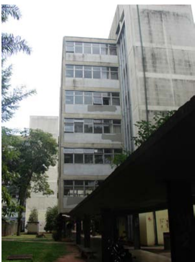
Fig. 94: CRUSP, encontro bloco-passagem coberta.
