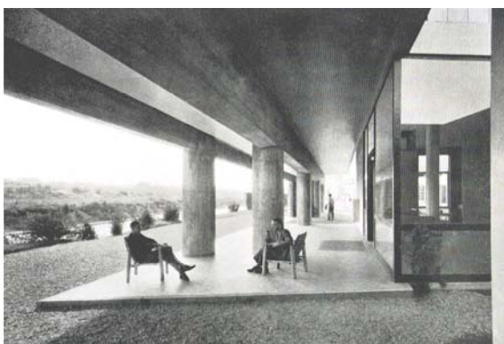
Fig. 37: Pavilhão Suíço, barra sobre pilotis.
