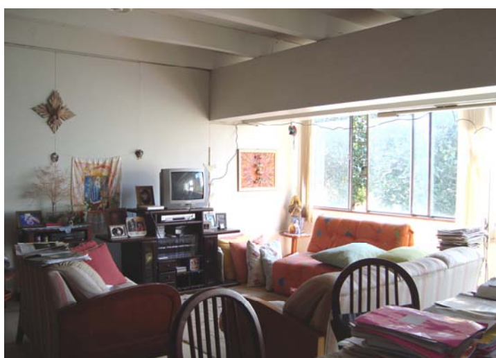
Fig. 55: Elementos estruturais aparentes no interior.
