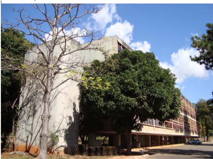
Fig. 90: Vista da escada secundária.
