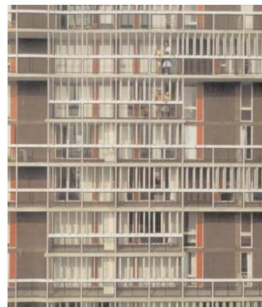
Fig. 89: Peabody Terrace, detalhe da fachada em grelha.
