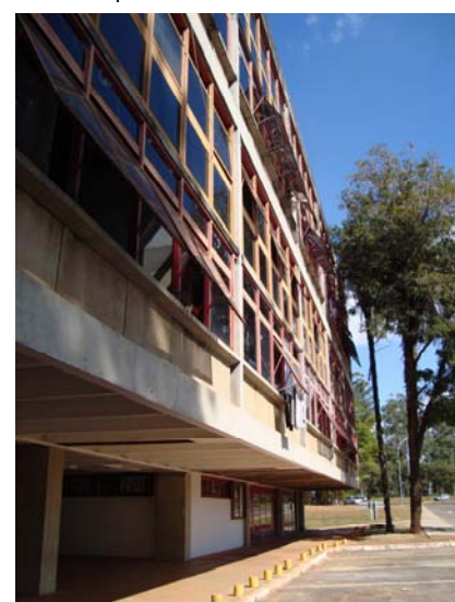
Fig. 85: Área em balanço.
