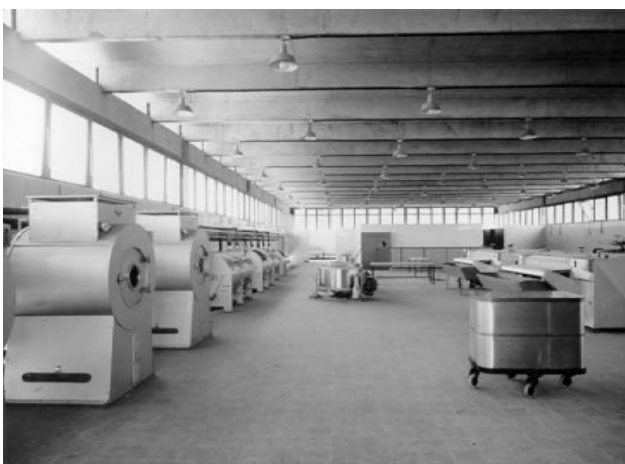
Fig. 87: CRUSP, lavanderia construída em 1966.
