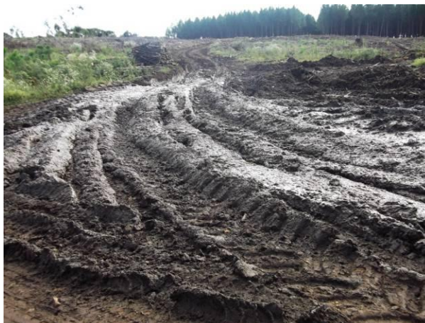
FIGURA 20: estrada impactada pela passagem dos caminhões e maquinários utilizados pelo setor madeireiro na localidade da Linha Caçador, CANELA/RS.
