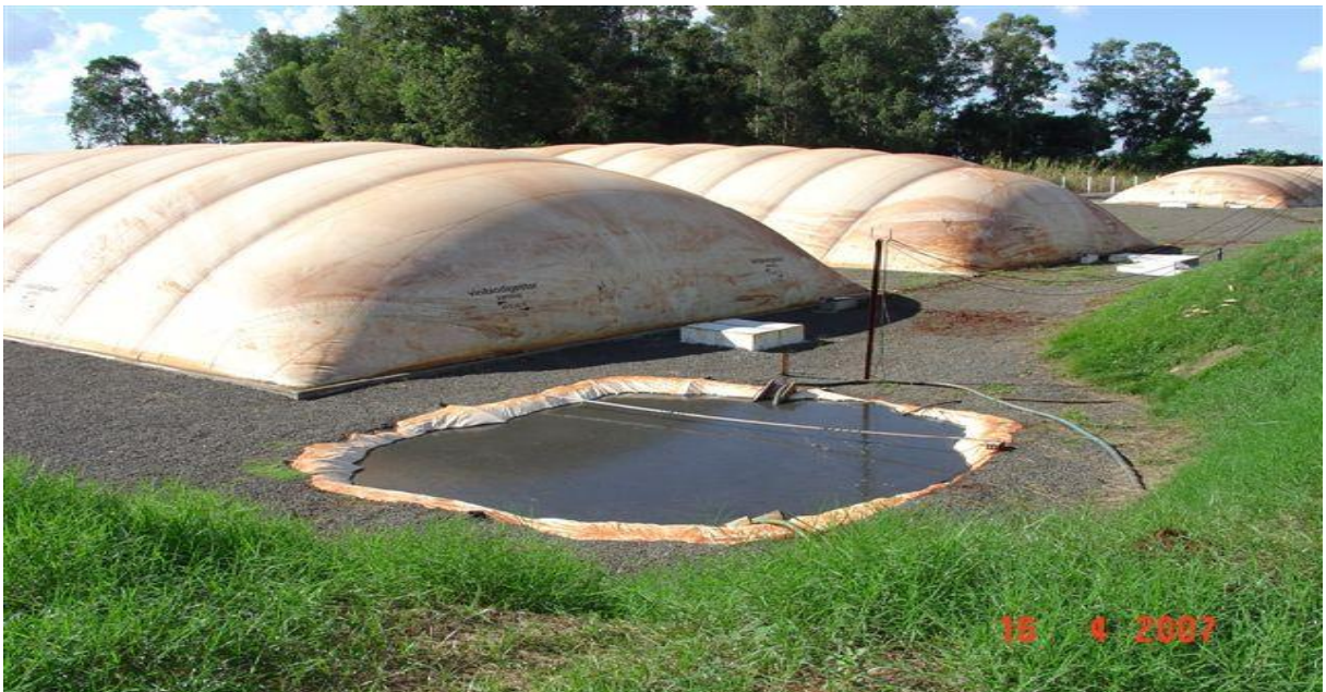
Figura 7 - Biodigestor e tanque de coleta e armazenagem dos dejetos estabilizados. Fonte: Pujol (2008).
