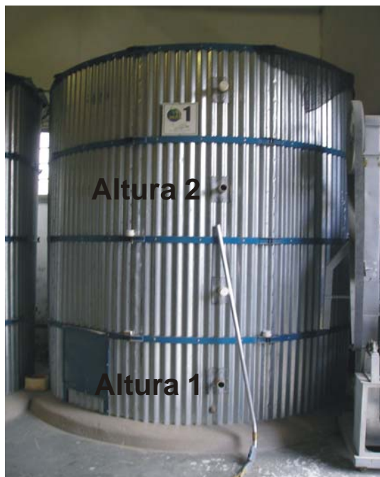
FIGURA 2. Silo metálico referente ao manejo de secagem e armazenamento estacionário, indicando as duas alturas analisadas.
