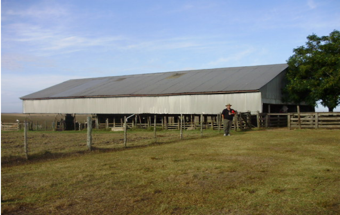
Figura 13: fachada externa da cabanha, ângulo lateral.
