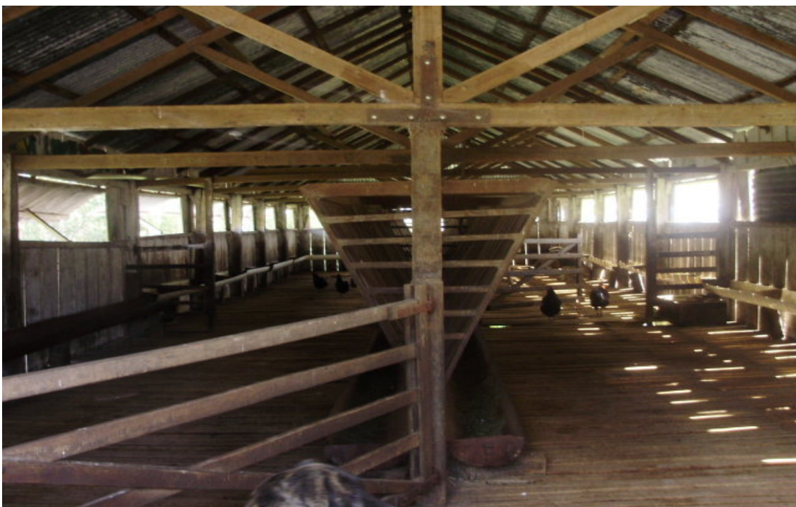
Figura 20: vista interna do galpão menor.
