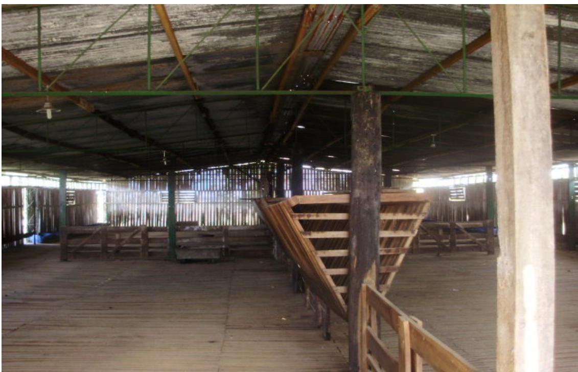
Figura 22: parte interna do galpão maior.
