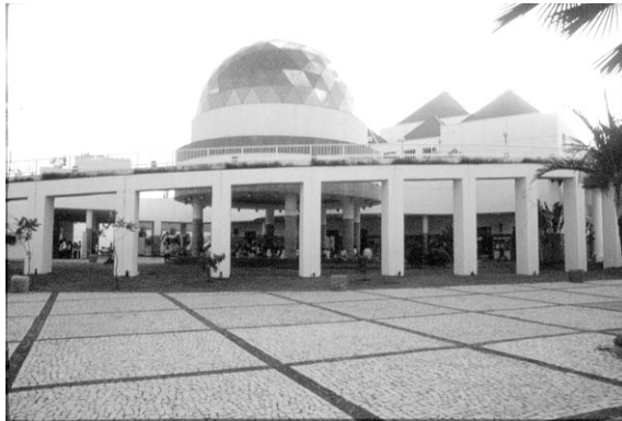
FIGURA 29 - Vista PLanetário do Centro Cultural Dragão do Mar.
