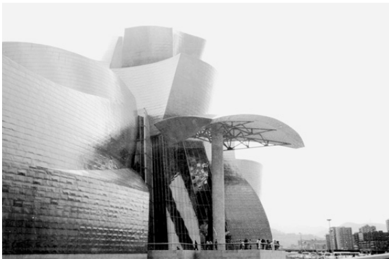
FIGURA 11 - Guggenheim Bilbao / detalhe da elevação sul.
