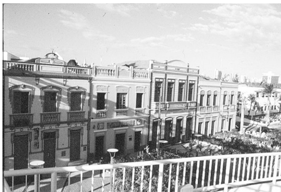
FIGURA 30 - Conjunto de sobrados vizinhos ao Dragão do Mar.
