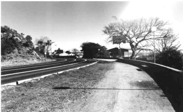
FIGURA 21 - Área contínua ao Museu Iberê Camargo com o estaleiro Só ao fundo.
