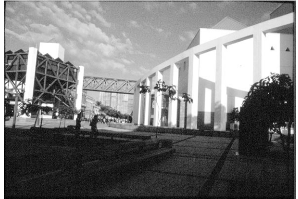
FIGURA 31 - Vista Centro Cultural Dragão do Mar.
