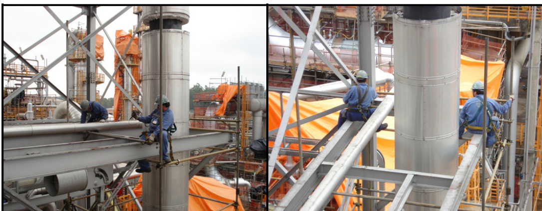
Figura 10 – Montagem de andaime em parada de manutenção.
