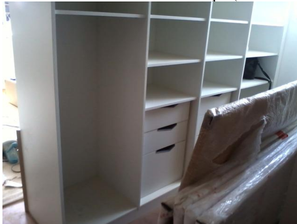
Figura 21 – Foto de um ambiente ‘closet’ em instalação (Data: 12/11/2011)
