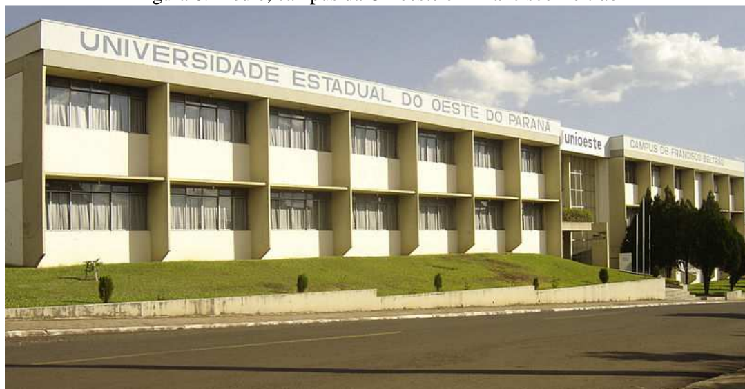
Figura 6. Prédio, campus da Unioeste em Francisco Beltrão
