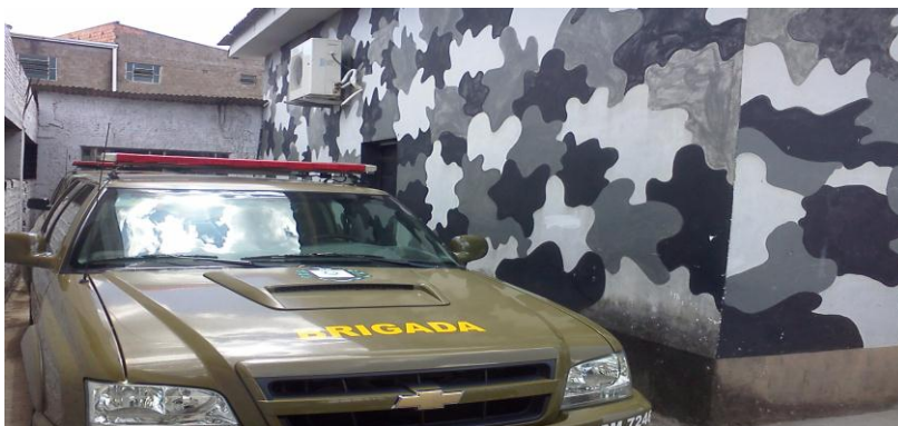
Imagem 4: Parte da lateral do prédio do POE do 25º Batalhão
