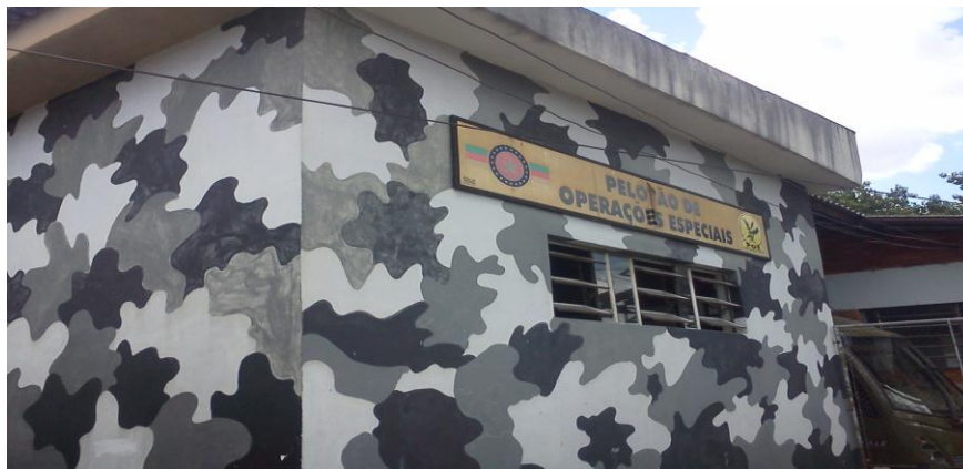
Imagem 3 - Fachada do prédio do POE do 25º Batalhão
