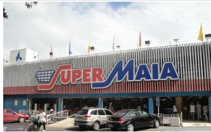
Figura 31- Fachada da Loja Super Maia 508 Sul.
