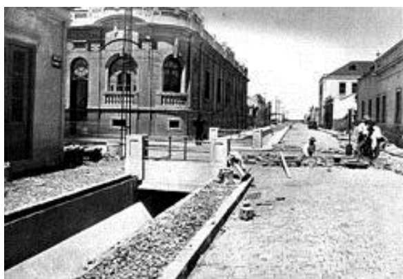
Figura 136: Os canaletes sanitários que tinham como principais funções o escoamento das águas pluviais, para drenagem urbana, são característica marcante dos principais projetos de saneamento elaborados pelo engenheiro Saturnino de Brito. Na foto ao lado, “Canalete em construção na rua General Argolo (sic)” (SOP, Relatório de 1929a, 1 v.: 24), na cidade Pelotas.
