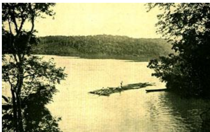
Figura 180: “Comissão de águas de Irahy 756 . Balsa entrando no Arroio do Mel (sic)” (SOP, Relatório de 1921b, 2 v, s/p.) 757 .
