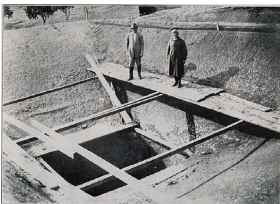
“Excavação do tanque Imhoff – Bananeiras (sic)” (SOP, Directoria das Obras Publicas , 1927d, s/p.).
