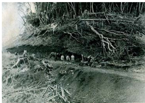
Figuras 161 e 162: Na foto à esquerda (Figura 161), “Estrada em construção para as fontes do „Mel” – Trabalhos sumários de terraplenagem para o prompto acesso (sic)” (SOP, Relatório de 1919a, s/p.). Na foto à direita, “Estrada em construção para as fontes do „Mel” – Derrubada na entrada do matto e ligeira terraplenagem (sic)” (SOP, Relatório de 1919a, s/p.).
