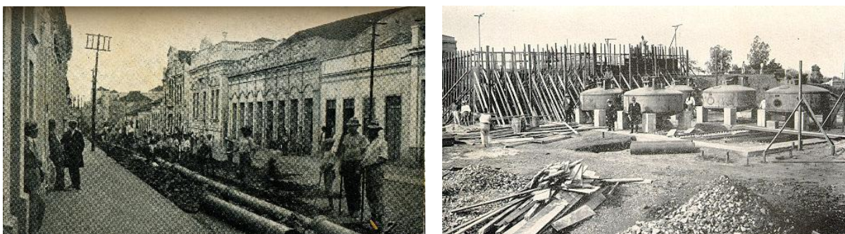
Figuras 126 e 127: Na imagem, à esquerda (Figura 126) observa-se o assentamento de condutos, em uma via pública, da cidade de Cruz Alta (SOP, Relatório de 1929b, 2 v., s/p.). Na ilustração, à direita (Figura 127): “Assentamento dos filtros rápidos (sic)” para o saneamento da cidade de Uruguaiiana (SOP, Relatório de 1929b, 2 v., s/p.).
