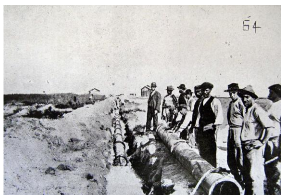
“Assentamento da linha tronco de 24” na Hydraulica” (INTENDENCIA MUNICIPAL DO RIO GRANDE, 1924, s/p.).
