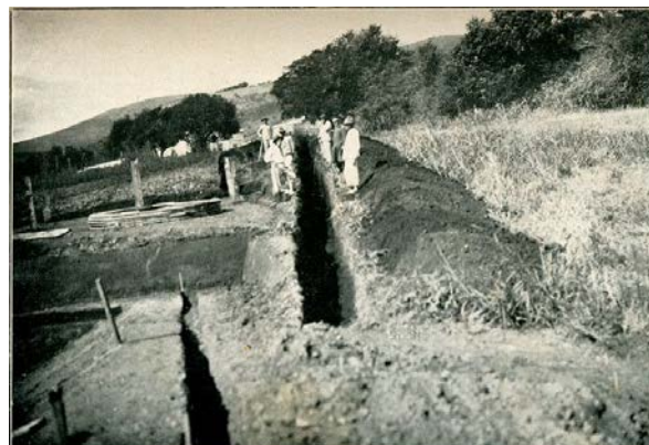
“Collector de exgottos – Bananeiras (sic)” (SOP, Relatório de 1928b, 2 v., s/p.).
