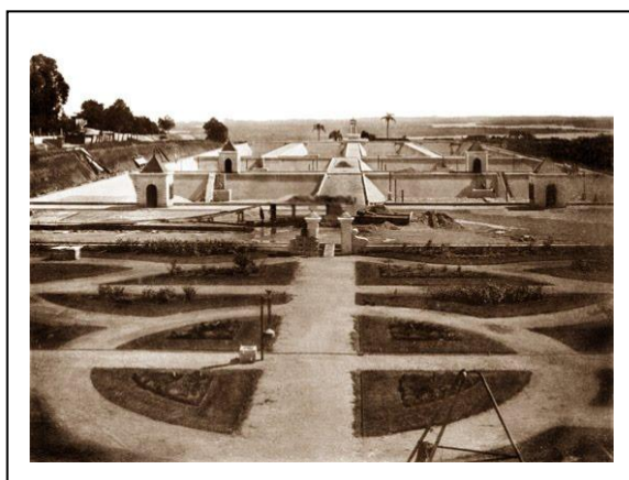
Figura 58: Tanques ainda em construção da Companhia Hydraulica Guahybense , (sic) em imagem datada de 1890. Nesse mesmo local (altos do Bairro Moinhos de Vento) atualmente se encontra a hidráulica do Moinhos de Vento, que pertence ao DMAE (PORTO ALEGRE UMA HISTÓRIA FOTOGRÁFICA, 25 jan. 2011).
