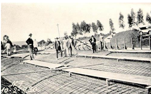
Figuras 128 e 129: Na gravura, à esquerda (Figura 128): “Saneamento de Livramento. Cobertura em abobada do reservatório (sic)” (SOP, Relatório de 1929b, 2 v., s/p.). Na ilustração, à direita (Figura 129): “Saneamento de Santa Maria. Passagem elevada da linha adductora d’agua (sic)” (SOP, Relatório de 1929b, 2 v., s/p.).
