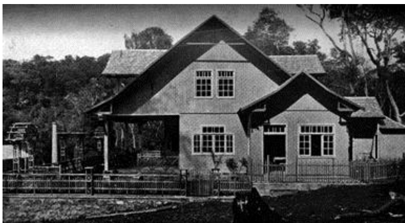
Figura 197: “Saneamento de Irahy. Posto medico. (sic)” (SOP, Relatório de 1930a, 1 v., s/p.), outra edificação, mais bem acabada, que mostra a evolução que o povoado vinha tendo.
