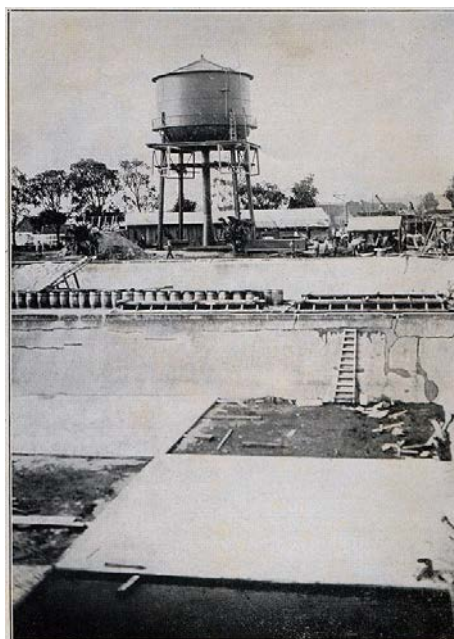
“Reservatorio elevado de lavagem dos filtros lentos para a camara de decantação – Porto Alegre (sic)” (SOP, Relatório da 1928b, 2 v., s/p.).
