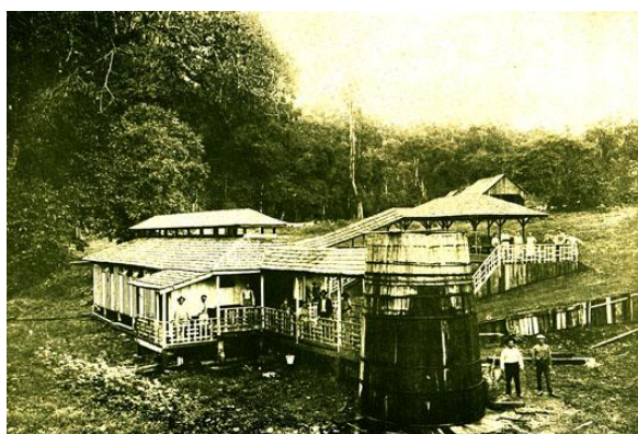
Figuras 186 e 187: Duas imagens de meados da década de 1920, nas quais se vê a infraestrutura do balneário, propriamente dito, de Iraí. Na imagem à esquerda (Figura 186) se vê, em primeiro plano, o tonel de armazenamento da água captada (SOP, Relatório de 1925b 2 v., s/p.).
