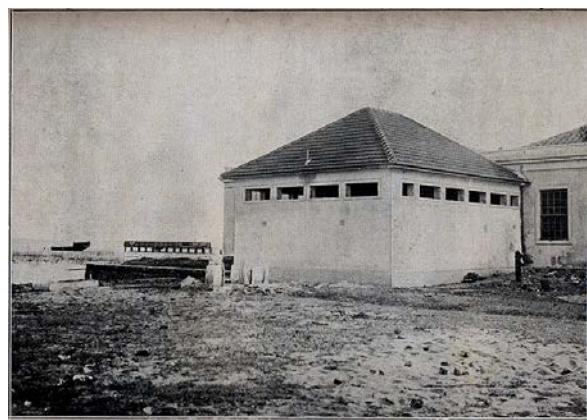
“Vista do Pavilhão Sanitário – Quartel do Crystal (sic)” (SOP, Relatório de 1928b, 2 v. s/p.).
