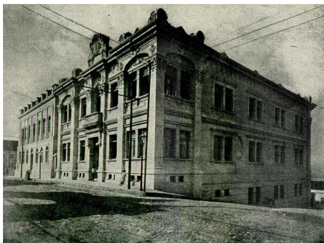
Ao lado: Prédio da Secretaria de Obras Públicas, “ Fachada principal e lado Oeste ”, (SOP, Relatório de 1909, s/p.).
